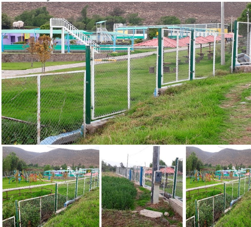
Figura 148 Borde de Rejas Metálicas.
