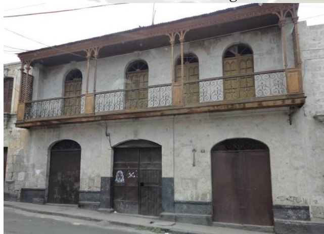
Figura 124 Casa en el distrito de Characato siglo XIX
