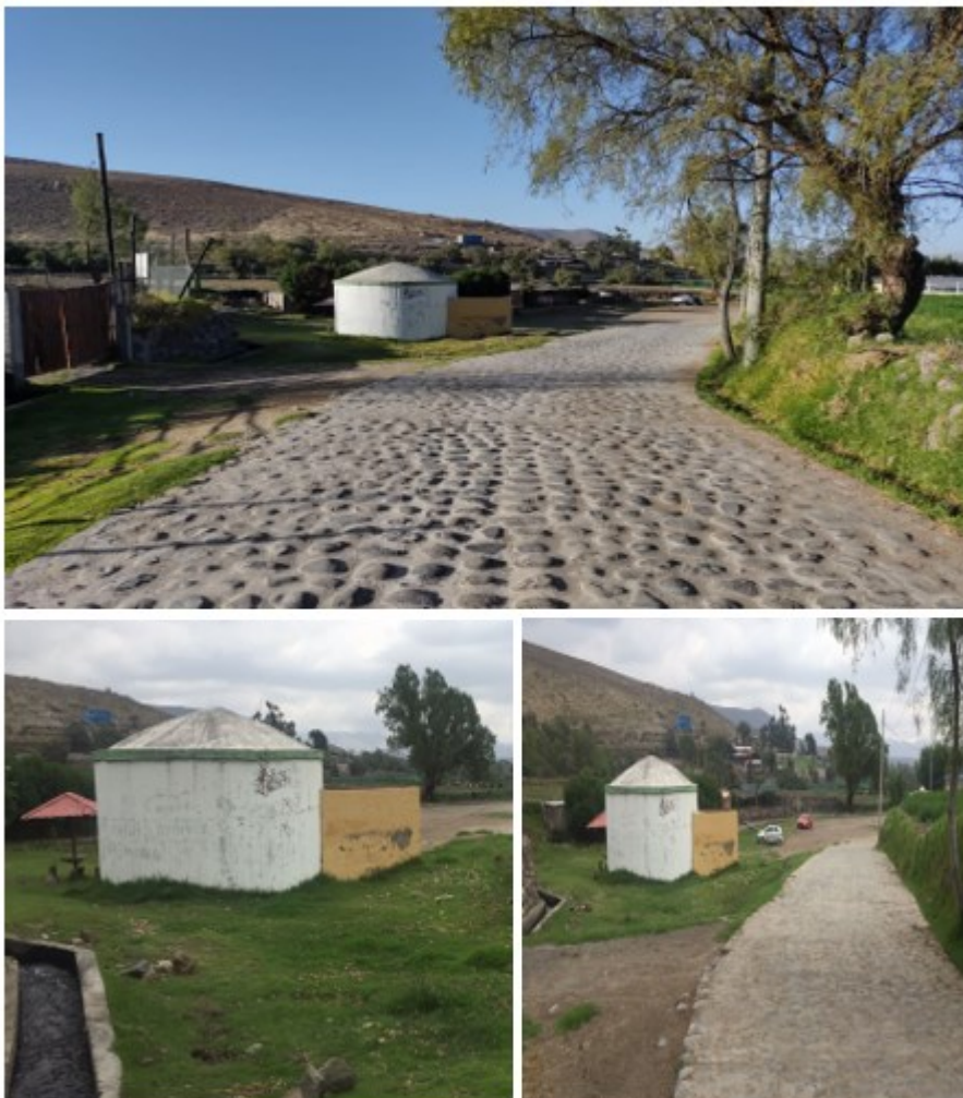
Figura147 Reservorio de Agua.
