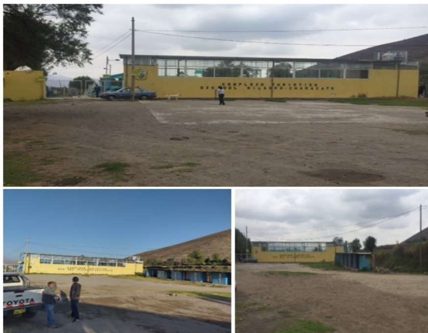
Figura 156 Ingreso Peatonal Puerta N° 01.
