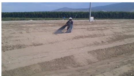
Instalación de mangueras para el riego
