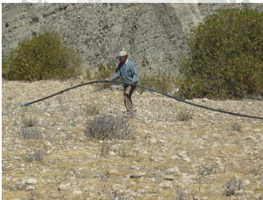
FOTOGRAFÍA 34. Instalación de líneas laterales con P.E. Ø 32 mm. (Chipicpita)
