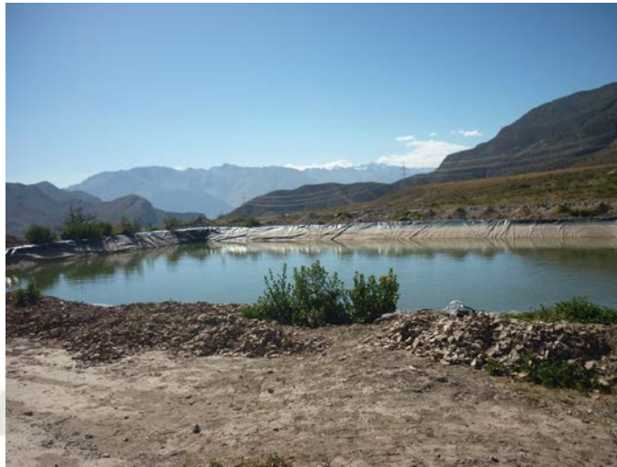
FOTOGRAFÍA 30. Reservorio de tierra revestido con geomembrana (Chipicpita)
