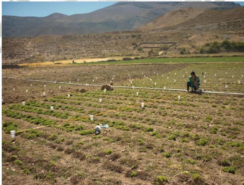
FOTOGRAFÍA 06. Instalación del Sistema de Riego por Aspersión (Sector Abrampampa)
