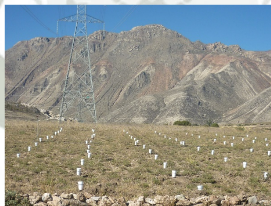
FOTOGRAFÍA 27. Pluviómetros instalados en la tubería PEØ25 mm. (La Ponderosa)
