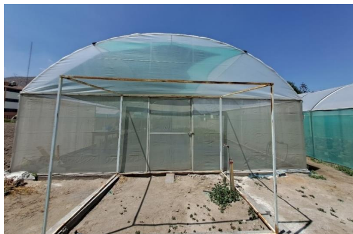
Figura N°4. Vista frontal del invernadero.
