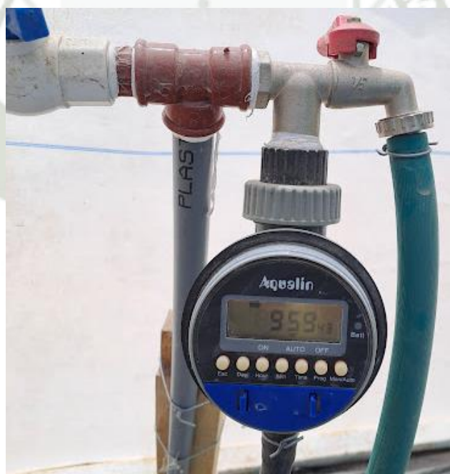
Figura N°7. Temporizador de Riego Aqualin instalado en el invernadero.
