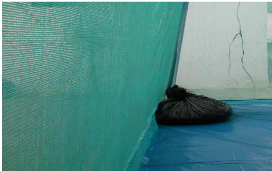
Figura N° 26 Colocación de Malla Ratschel.
