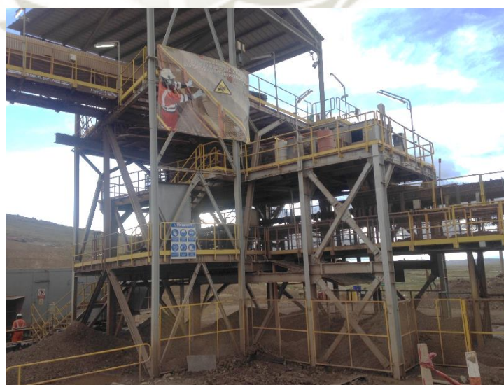
Figura 49. Instalación de Faja de Sacrificio en el Circuito de Chancado
