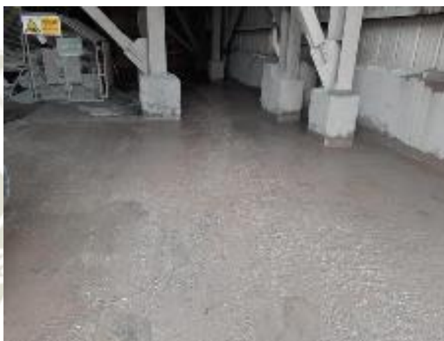
Figura 28. Limpieza del Circuito. Fuente: Elaboración propia.
