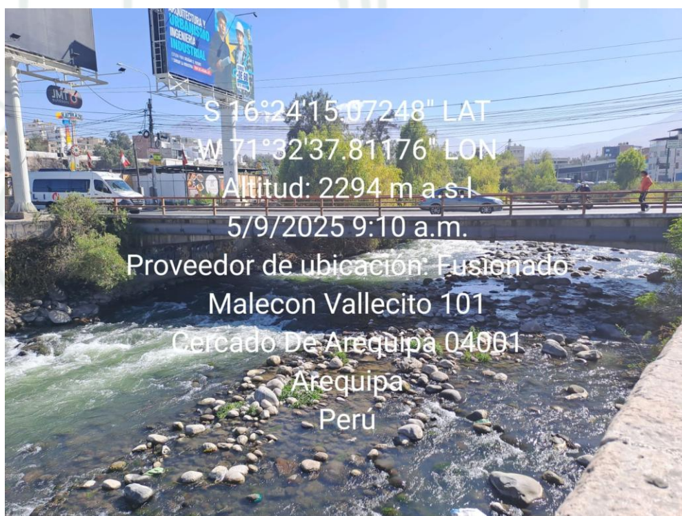
Estación 2: Puente San Martín
