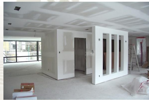
Figura 88: Construcción en Drywall
