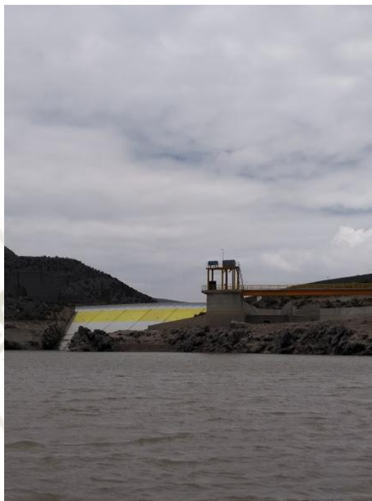
Figura 43 Estructura de la presa
