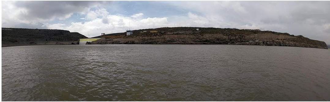
Figura 46 Vista panorámica de la represa Aguada Blanca
