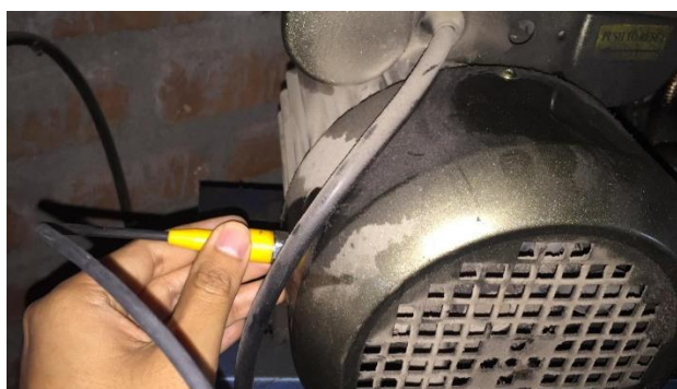
Figura 106: Medición en posición horizontal del motor 2HP
