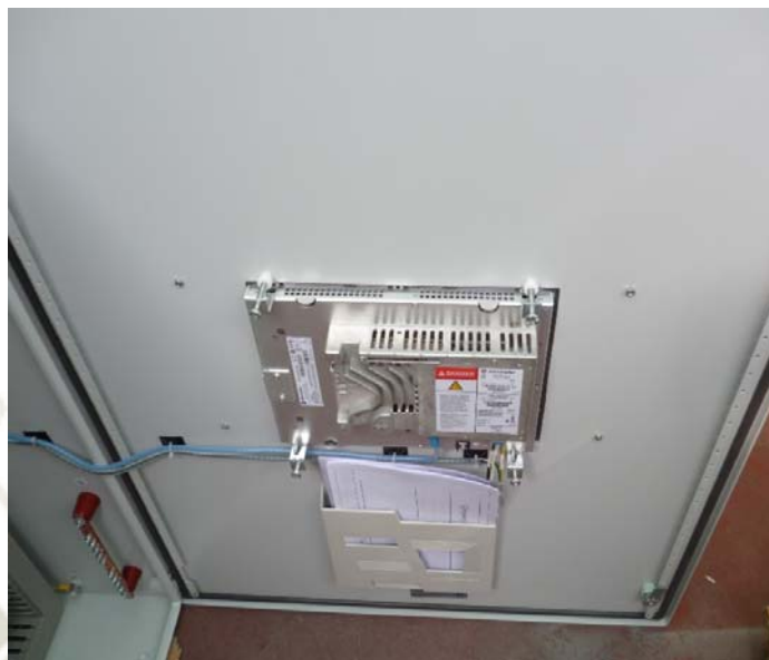
Figura N°35. Montaje de PanelView Plus 6 en puerta de tablero
