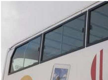
Instalación de ventanas
