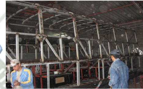
Ensamble de estructura
