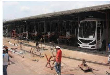
Habilitado y pintado de tubos
