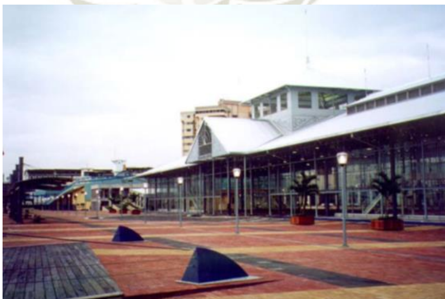
Imagen 45. Malecón 2000 Guayaquil – Sistema constructivo Mercado sur
