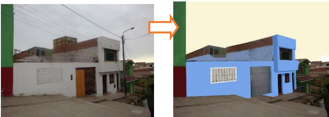
Imagen 71. Mantenimiento fachada Calle
