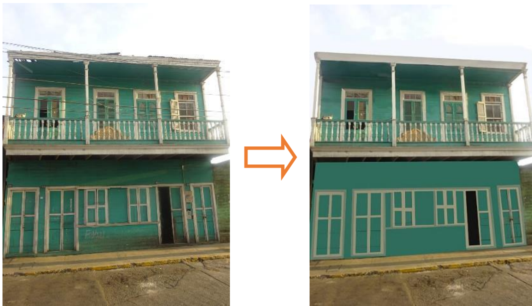
Imagen 81. Mantenimiento fachada calle
