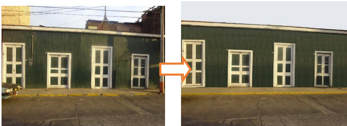
Imagen 82. Mantenimiento fachada calle
