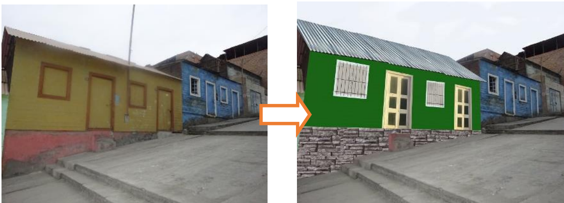
Imagen 73. Mantenimiento fachada Calle
