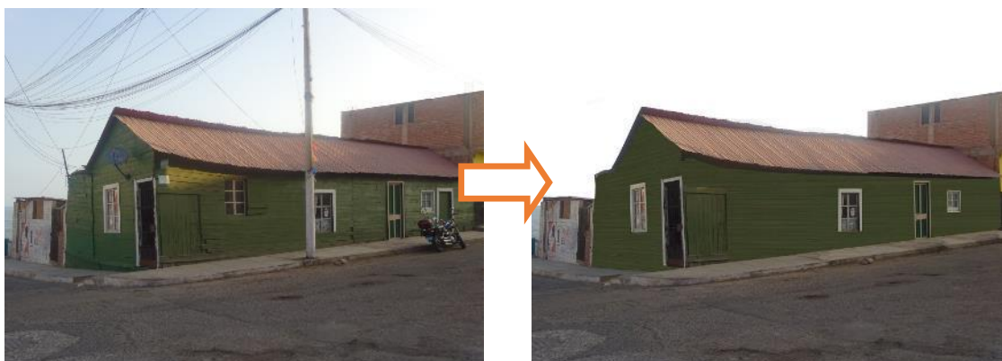
Imagen 77. Mantenimiento fachada Calle
