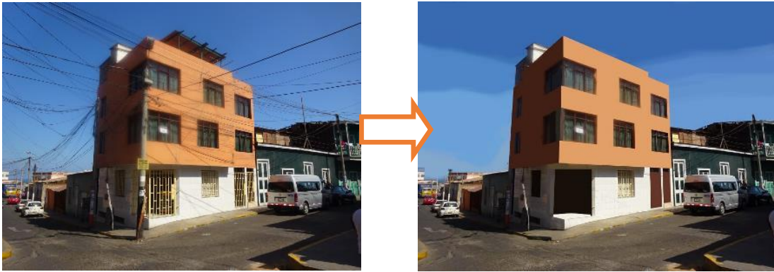
Imagen 69. Mantenimiento fachada Calle
