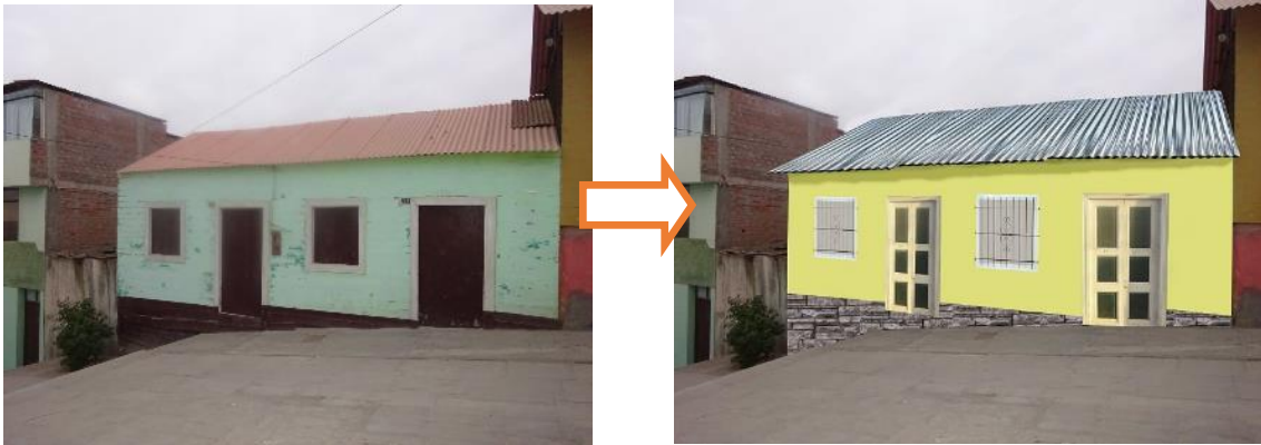
Imagen 72. Mantenimiento fachada Calle
