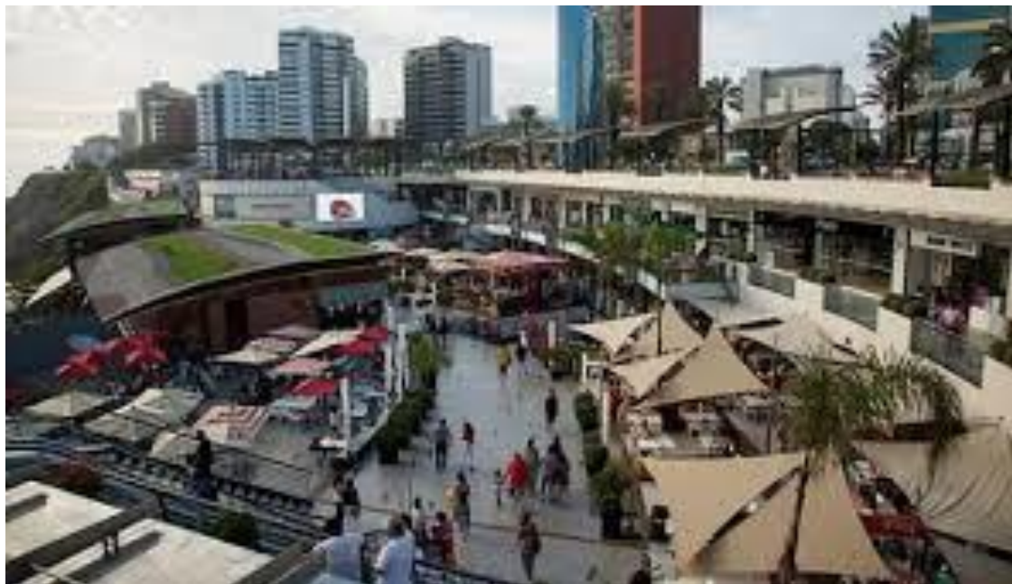
Imagen 32. Larcomar sistema Constructivo – tratamiento exterior
