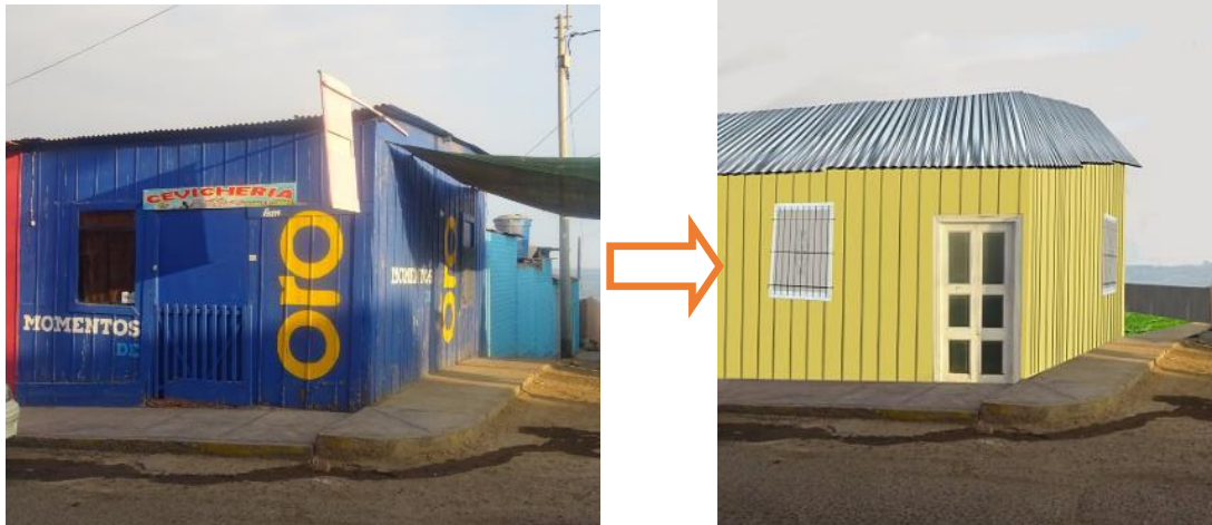
Imagen 78. Mantenimiento fachada Calle Islay
