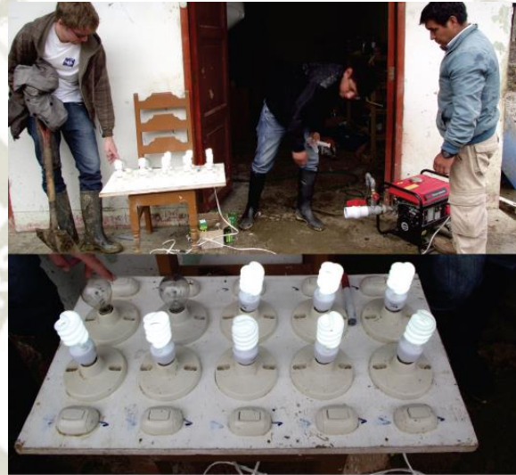
Figura 3: Generador Eléctrico 1 kW
