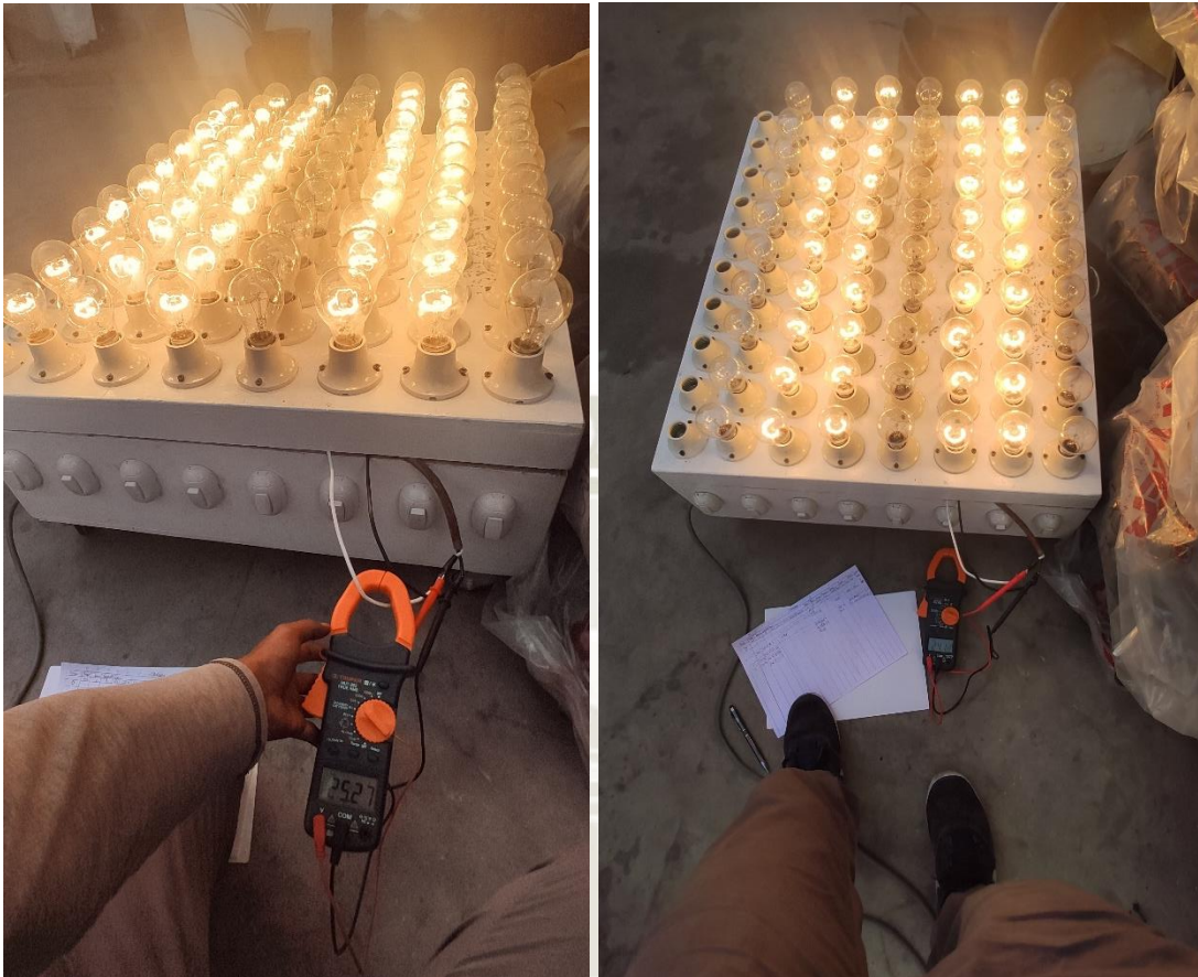
FOTO 4: MEDICIÓN DE POTENCIA EN MÓDULO FOCOS
