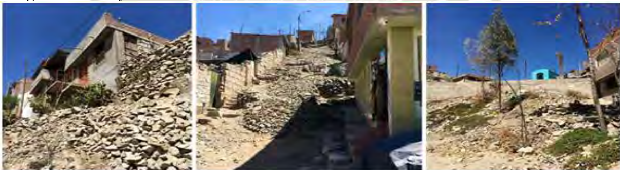
Figura 53. Riesgos de caídas y accidentes en PSDS
