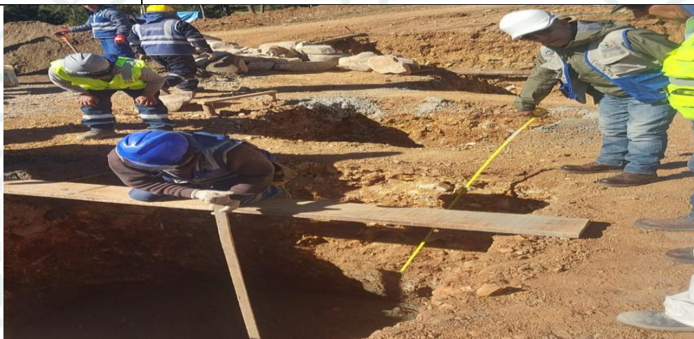
IMAGEN N°01: Verificación de las zapatas excavadas de los bloques
