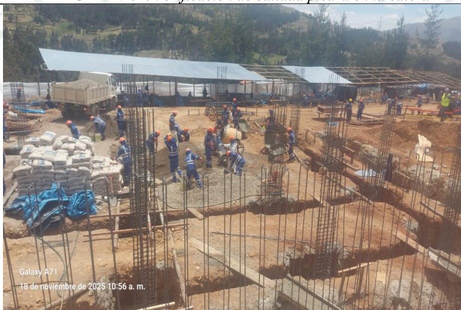
IMAGEN N°05: Verificación del izado de las columnas
