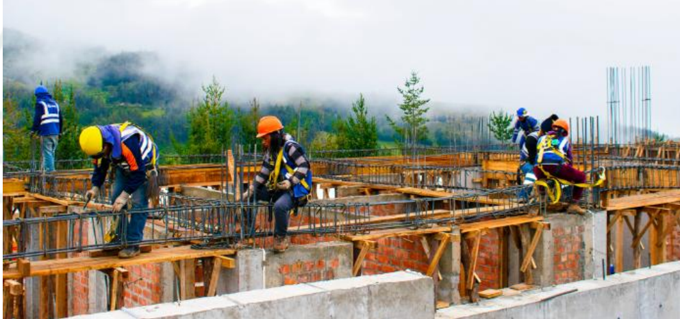
IMAGEN N°10: Trabajos de armado de estructuras en altura
