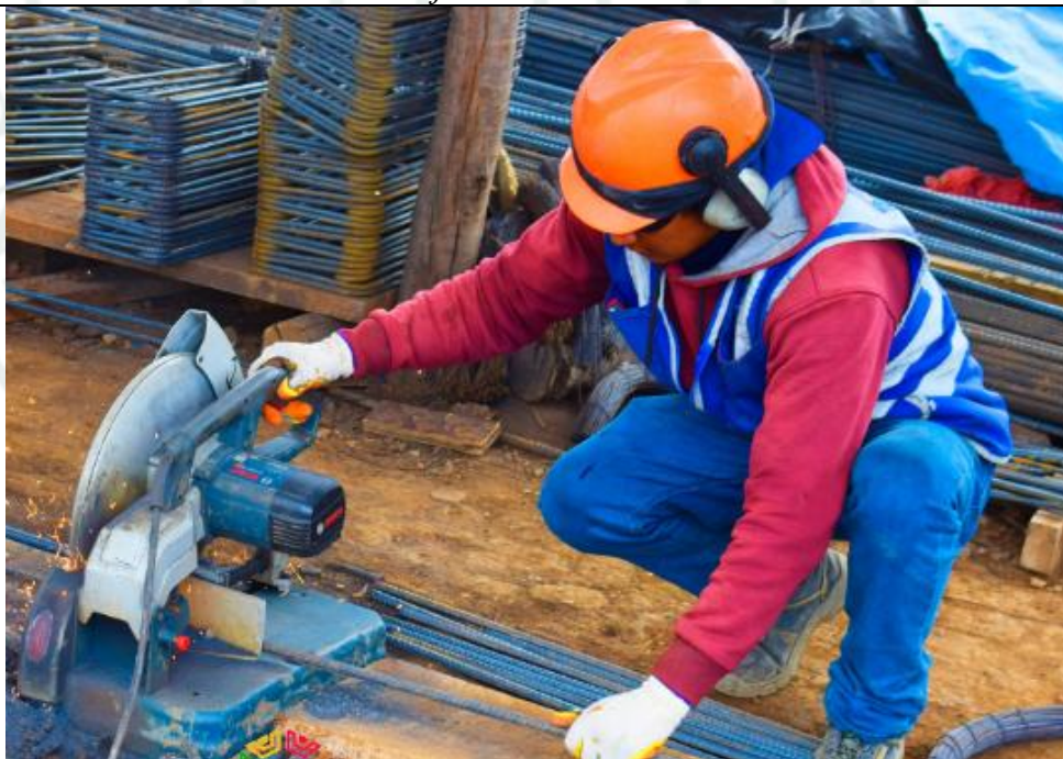
IMAGEN N°11: Trabajos de corte de fierros para armado de estructura
