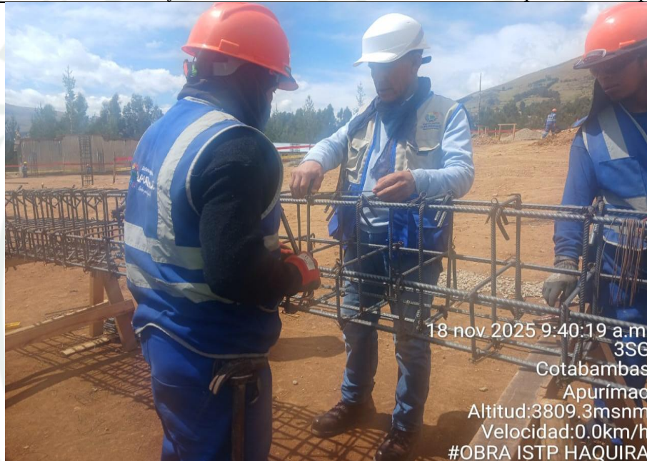
IMAGEN N°07: Verificación del armado de columna para los bloques
