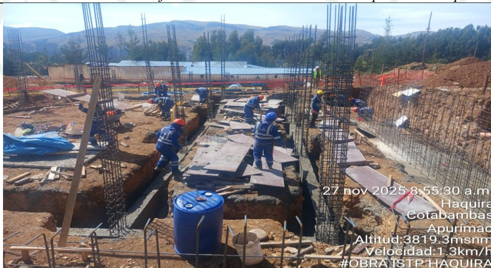
IMAGEN N°08: Verificación del izado de las columnas
