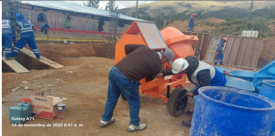
IMAGEN N°06: Verificación de la mezcladora de concreto para su recepción
