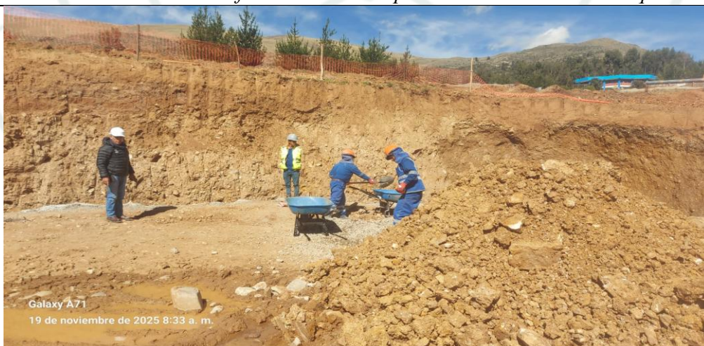
IMAGEN N°02: Verificación de acarreo de material excedente de la excavación
