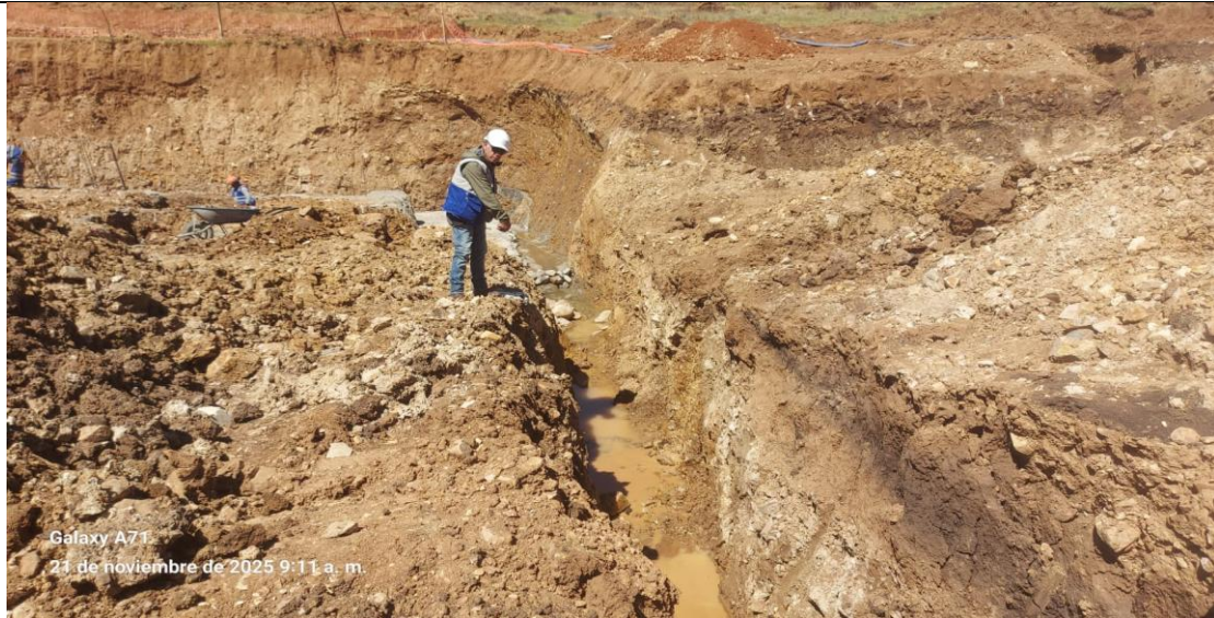
IMAGEN N°03: Aparición de agua subterránea durante la excavación
