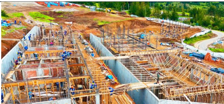
IMAGEN N°09: Captura aérea de la etapa estructural en ejecución del proyecto
