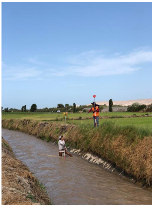
Observamos el levantamiento de la topografía para el tramo del canal de 0+200 m
