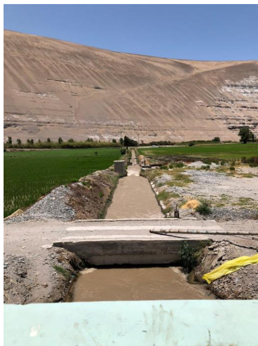
Observamos el canal a la salida de derivación de la bocatoma
