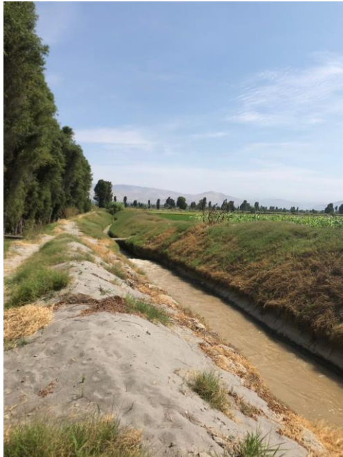
Observamos el canal con los cultivos en la zona y cambio de sección nuevamente
