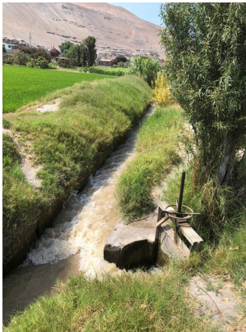
Observamos cambio brusco en la seccion del canal
