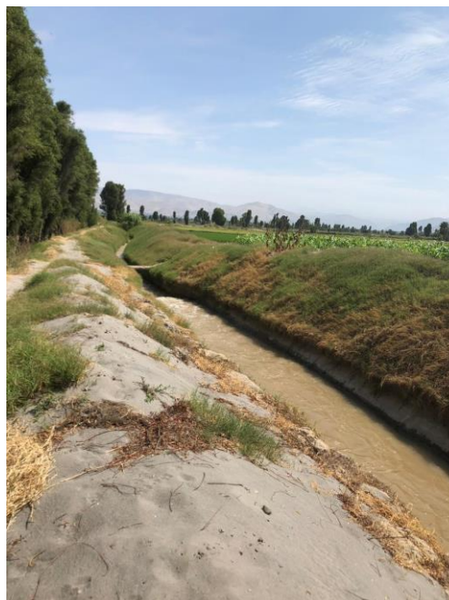
Observamos la presencia del canal para un caudal de 2 m 3 /s
