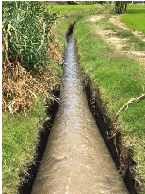
Observamos el canal con nuevamente cambio de seccion
