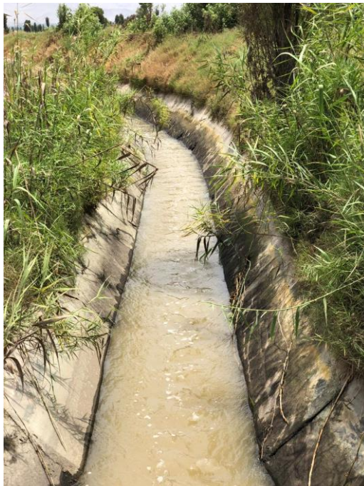
Observamos que la seccion del canal varia nuevamente
