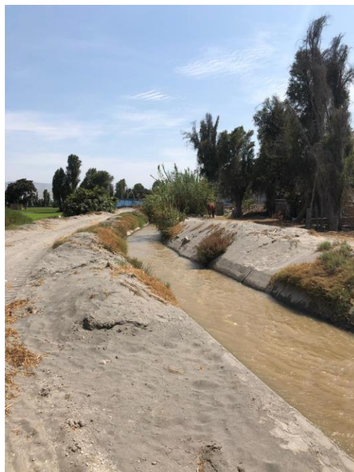
Observamos la presencia del canal de conducción a un lado de los cultivos tradicionales en la punta de bombon
