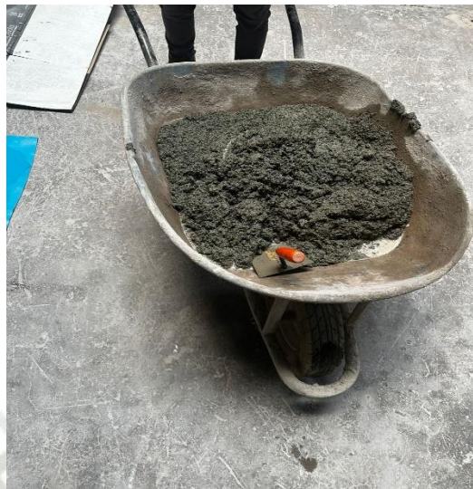
Ilustración 14. Mezcla de concreto adicionando HDPE Y PET
