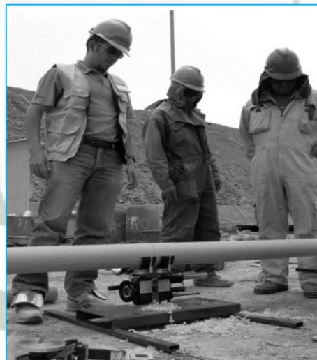
FIGURA Nº 42: SOLDADURA POR TERMOFUSIÓN
