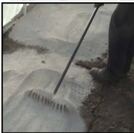
Fotografía 2: Colocacion de la piedra pomez.
