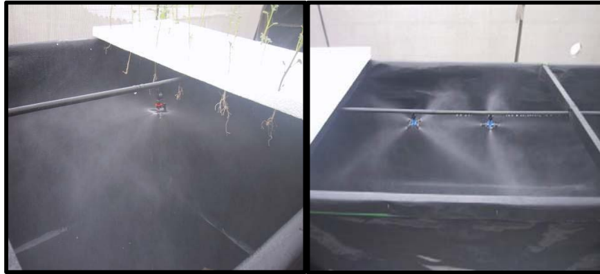
Fotografía 12: Instalacion de los nebulizadores.
