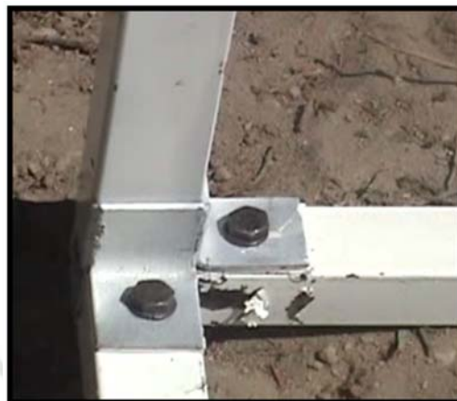
Fotografía 1: “L” metálica para acoplamiento de las piezas.
