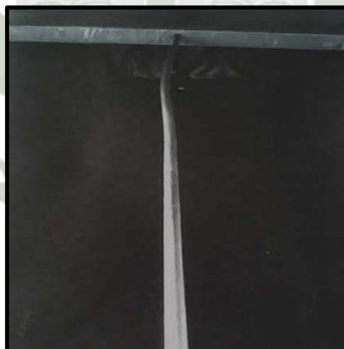
Fotografía 7: Instalacion de la manguera.
