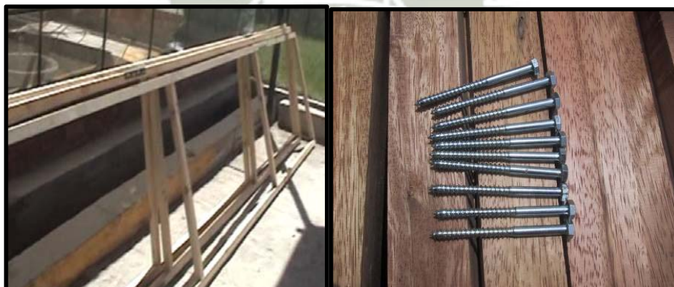
Fotografía 5: Construcción de los cajones, uso de Tirafones.
