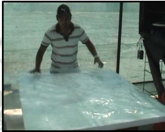
Fotografía 8: Corte e instalación de las planchas de tecnopor.
