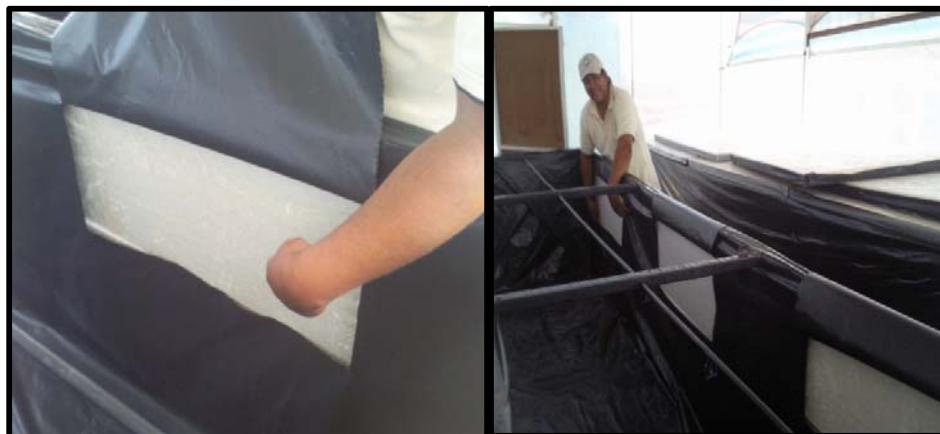
Fotografía 10: Corte y cobertura de los cajones con plástico negro (B).
