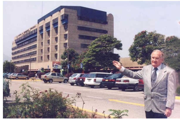
Figura 88: Foto del Centro hospitalario. (Fuente: INEN 2017)
