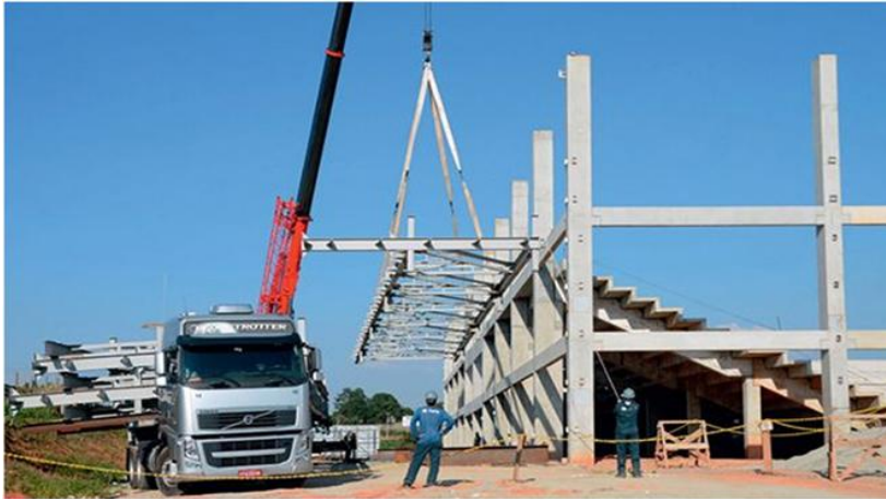
Figura 6: Traslado de estructura. (Fuente: construccionenacero.com 2018)
