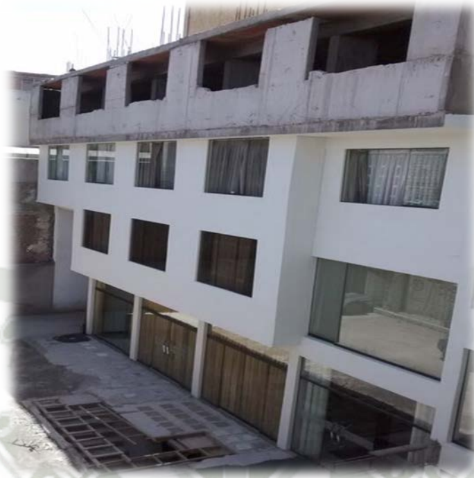
IMAGEN 17: Área en proceso de construcción
