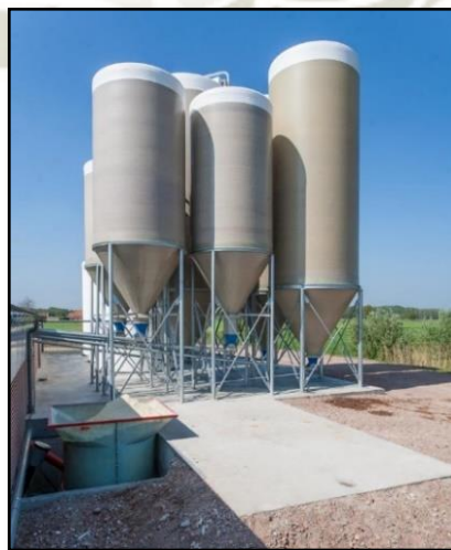
Figura 7. Celdas de silos de poliéster en forma circular
