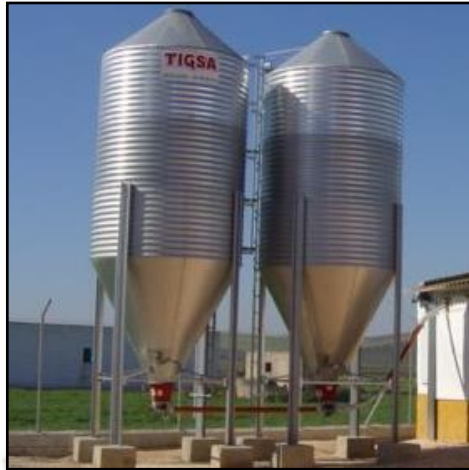
Figura 6. Silos metálicos en forma circular
