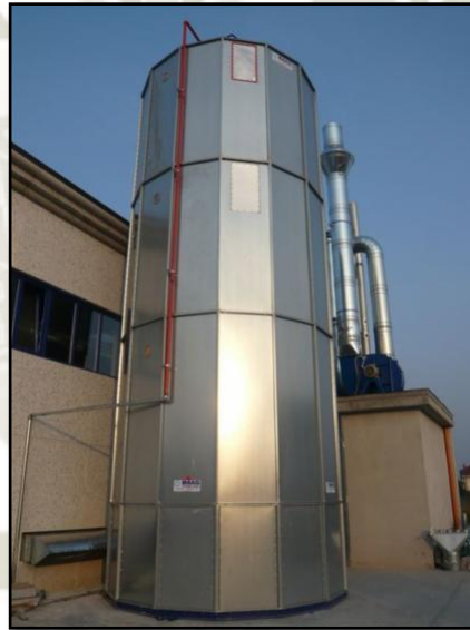
Figura 8. Silos metálicos en forma poligonal
