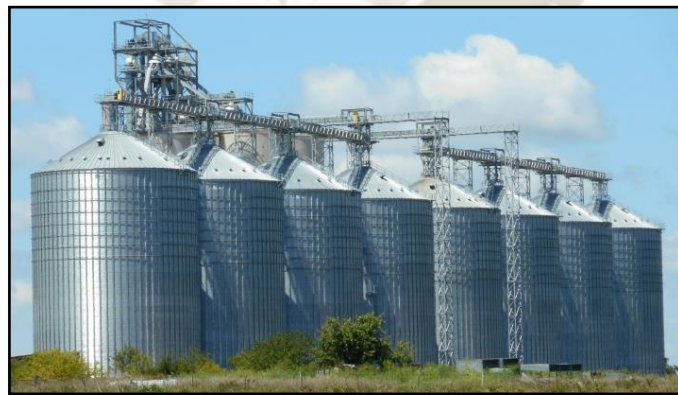
Figura 2. Silos metálicos de torre de agricultura
