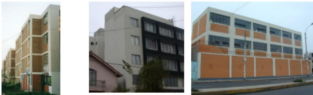
Fig. 2- Edificios de albañilería confinada (izquierda), Albañilería armada (centro) y edificios educativos (derecha), en Lima
