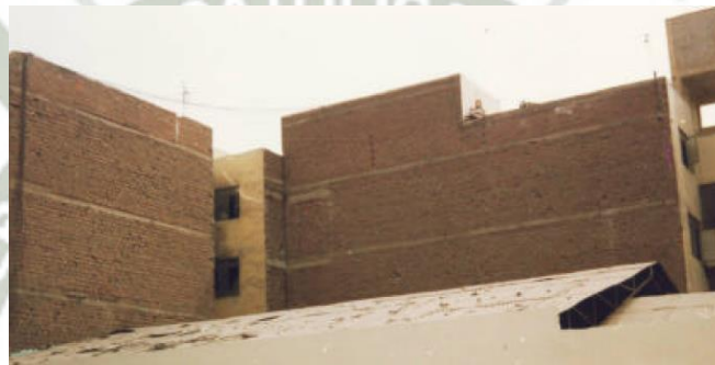
Fig1.- Edificio antiguo de albañilería simple Lima (San Bartolomé, 1994).
