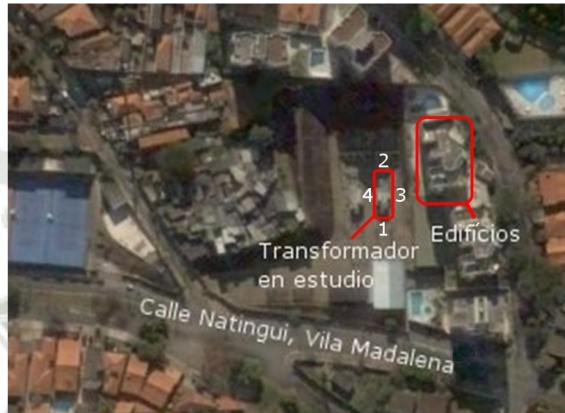
Figura 3.4: Localización de la Subestación Bela Aliança
