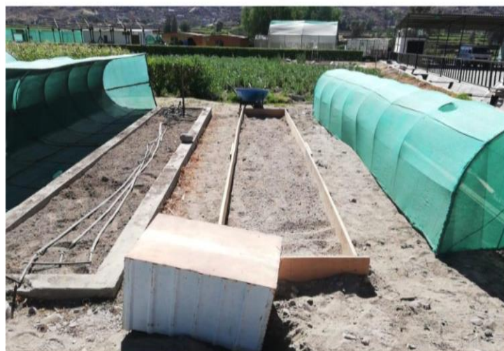
Fotografía N° 4. Instalación de cama de madera.
