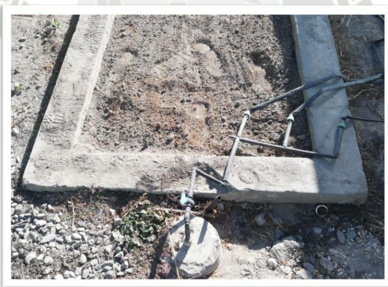
Fotografía N° 3. Conexión de mangueras.
