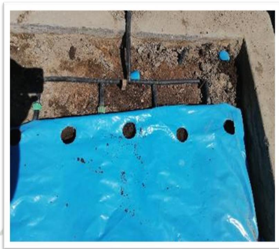
Fotografía N° 14. Colocación de cobertura de plástico.
