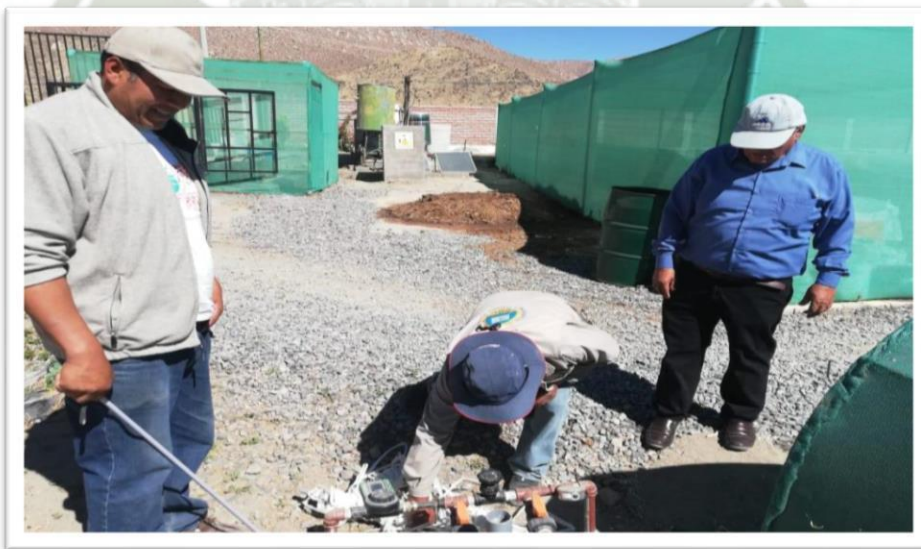
Fotografía N° 1. Instalación de sistema de riego por goteo.
