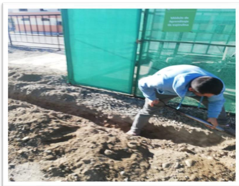
Fotografía N° 2. Zanja para la tubería.
