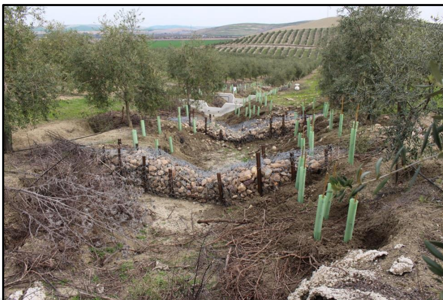
Figura 23: Diques de contención (imagen referencial)
