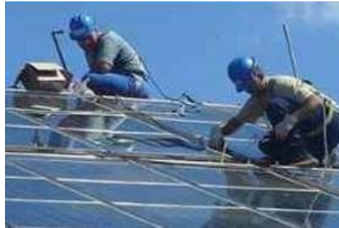
Figura 46: Instalación de un sistema fotovoltaico con seguridad
