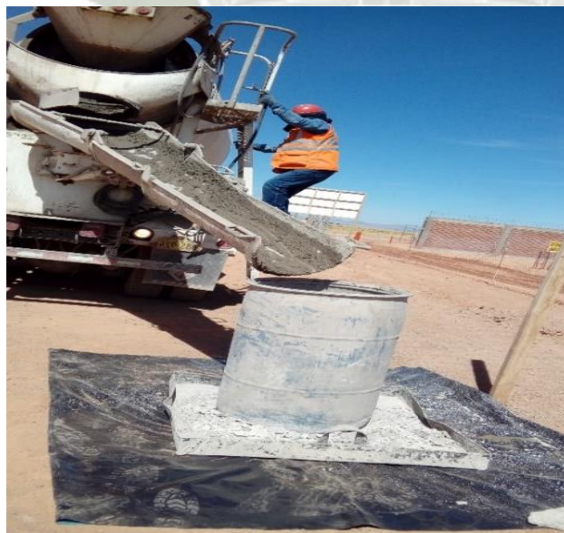
Figura N°10 Zona de lavado de canaletas.
