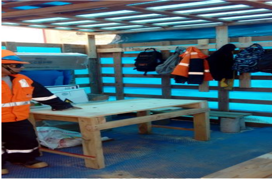
Figura N°7: Habilitación temporal de espacios, reutilizando las maderas. .
