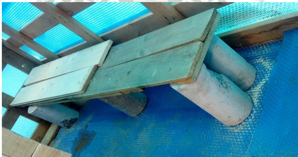
Figura N°8: Habilitación temporal de bancos, reutilizando maderas y probetas de concreto.
