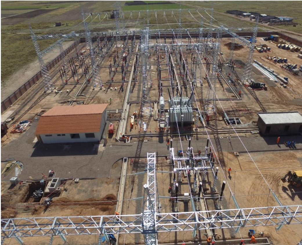
Montaje de estructuras. 2 de Octubre del 2017.
