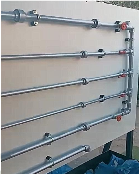
Figura 60. Montaje de trayectorias y válvulas
