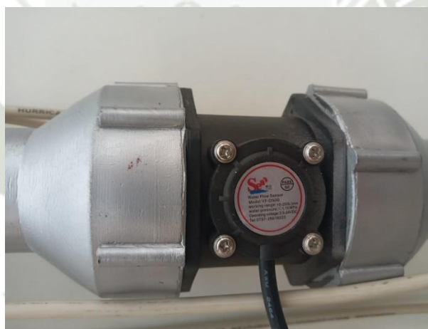
Figura 63. Instalación del sensor de caudal
