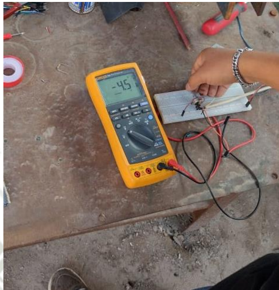
Figura 64. Pruebas de señal de transmisores de presión
