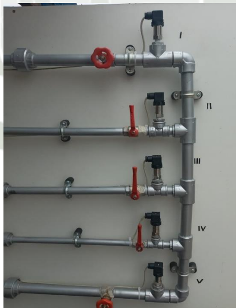
Figura 61. Instalación de transmisores de presión
