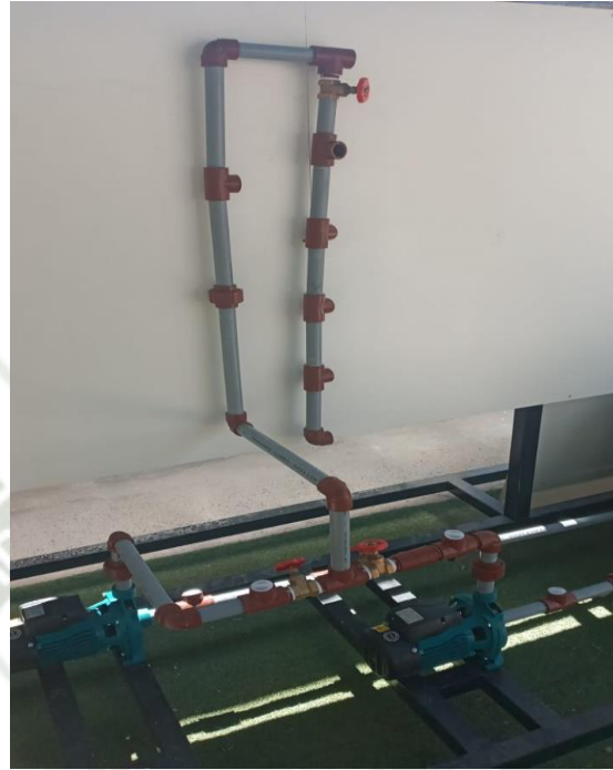
Figura 58. Montaje de tablero y bombas
