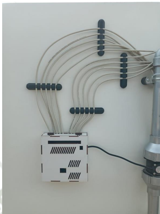
Figura 66. Tablero del sistema interconectado.
