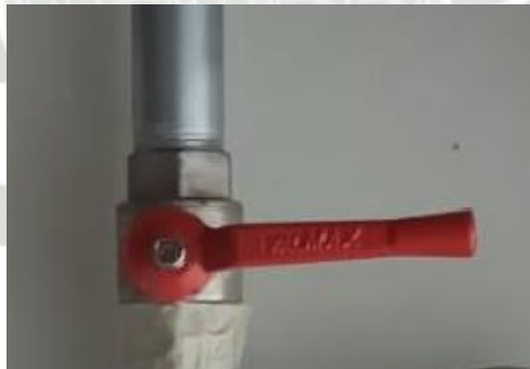
Figura 53. Válvula bola
