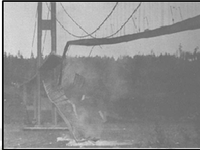
FIGURA # 033.- Puente de Tacoma en resonancia
