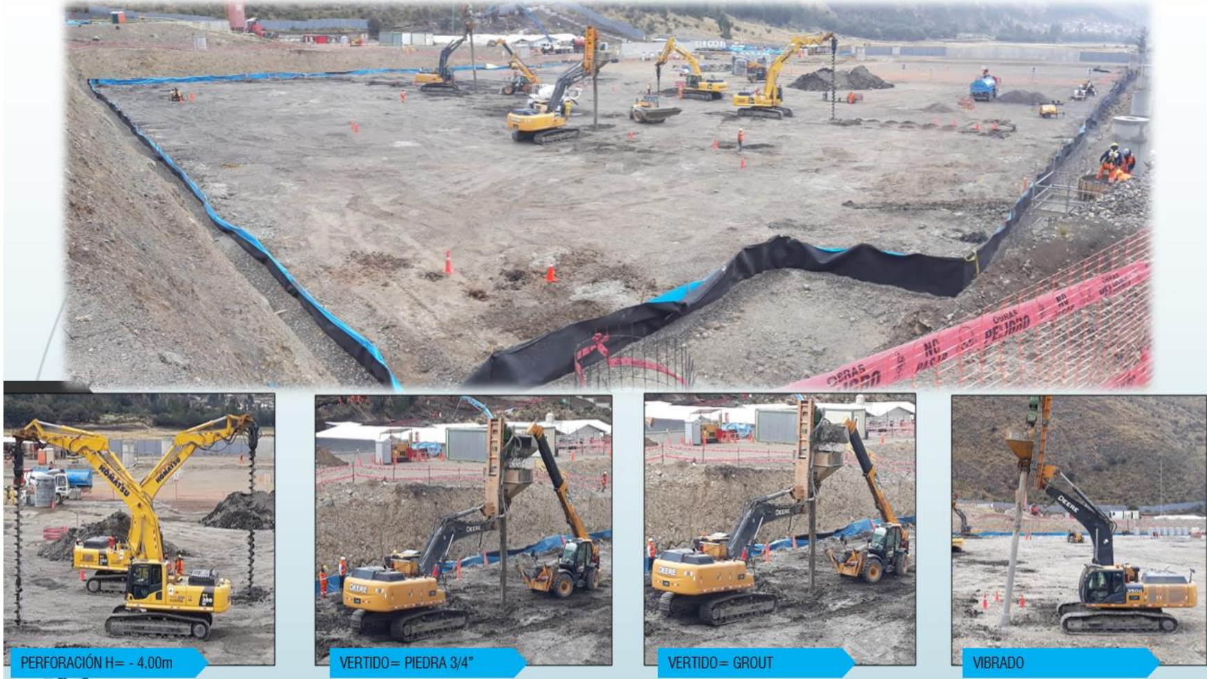
Figura 53 - Fotografía de Adicional N°01 Mejoramiento de Suelos en Plataforma. 01 Fuente: Elaboración Propia
