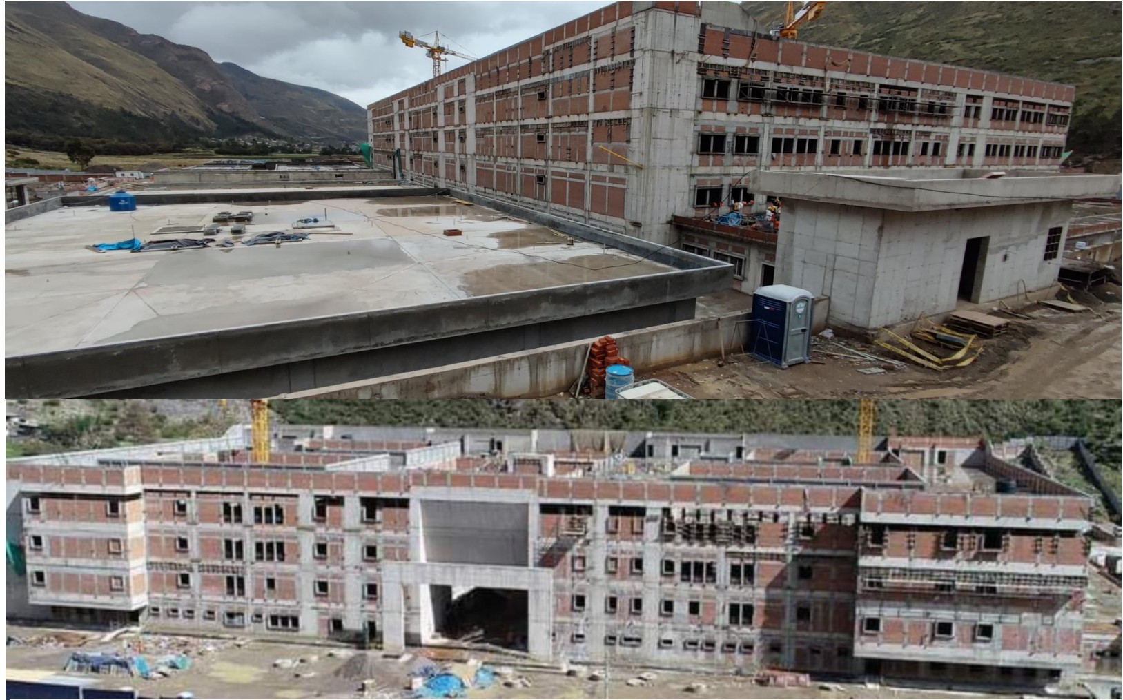
Figura 11 - Fotografías del Proceso de Construcción del Edificio principal Bloque A, y Bloque C Fuente: Elaboración Propia
