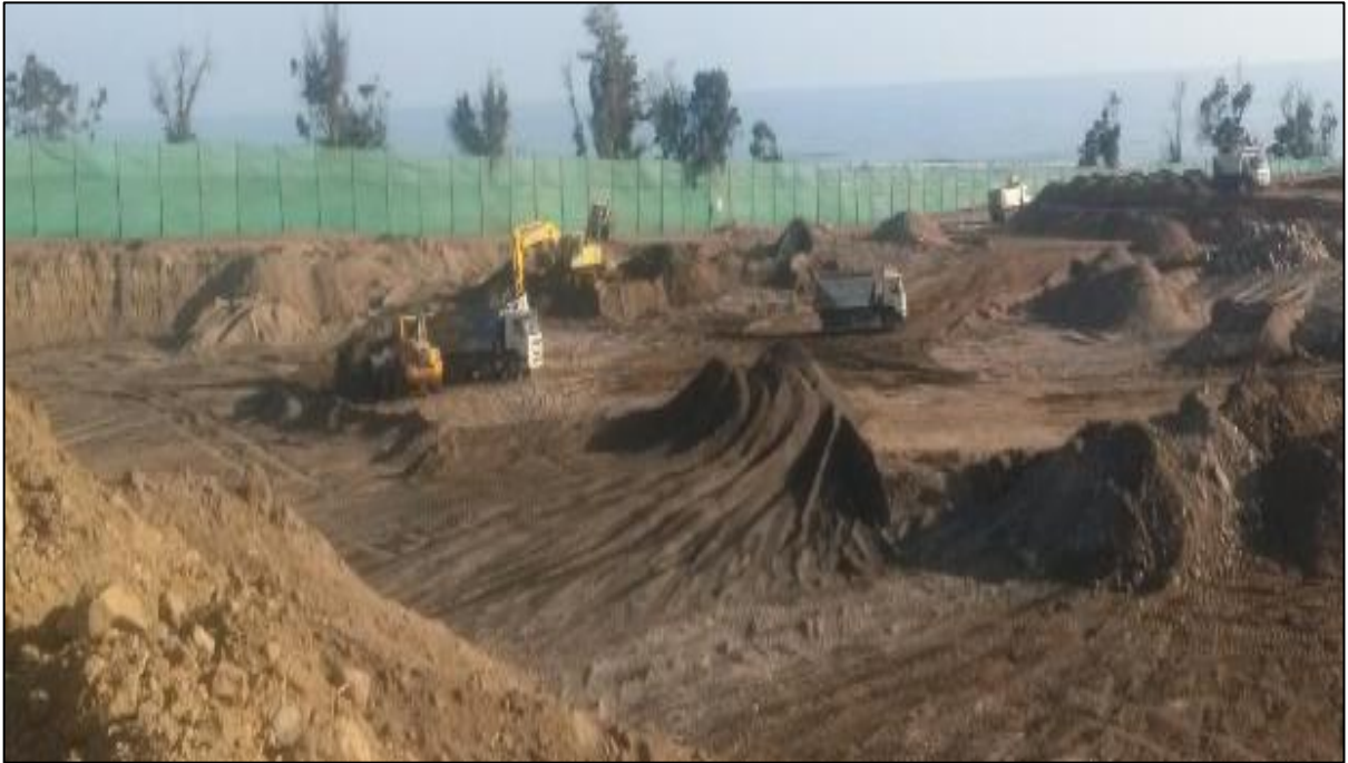
PROCESO 12. Corte y carguío del material arenoso y limoso presente en las plataformas 5 y 7.
