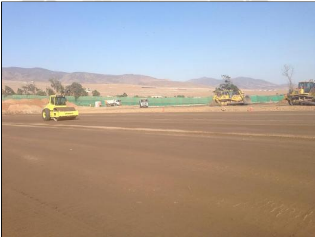
PROCESO 14. Descarga, conformación y compactación del relleno, en la plataformas 3.
