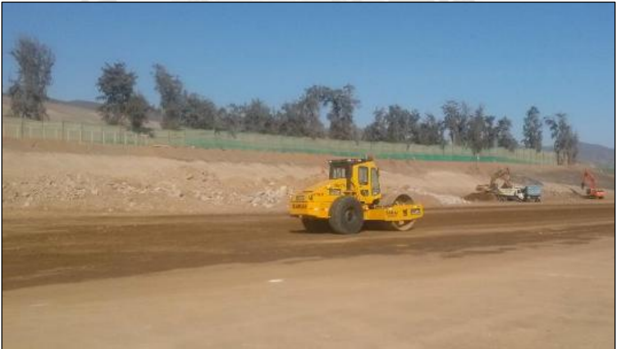
PROCESO 14. Compactación del material para entrega del terreno, Plataforma 2 y 4
