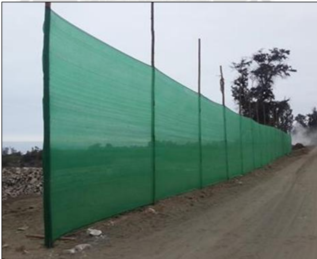
PROCESO 17. Instalación de malla Raschel a 4.2m.
