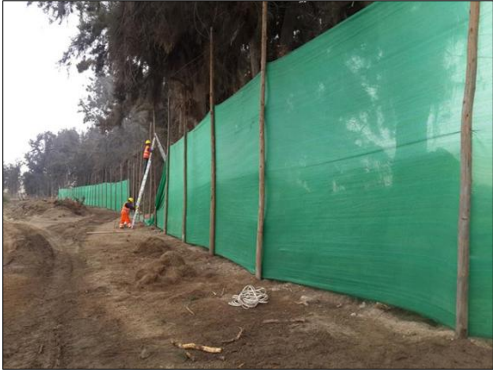
PROCESO 17. Instalación de malla Raschel a 4.2m.
