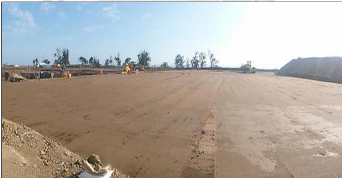
PROCESO 13. Conformación y compactación del relleno, en la plataformas 3.
