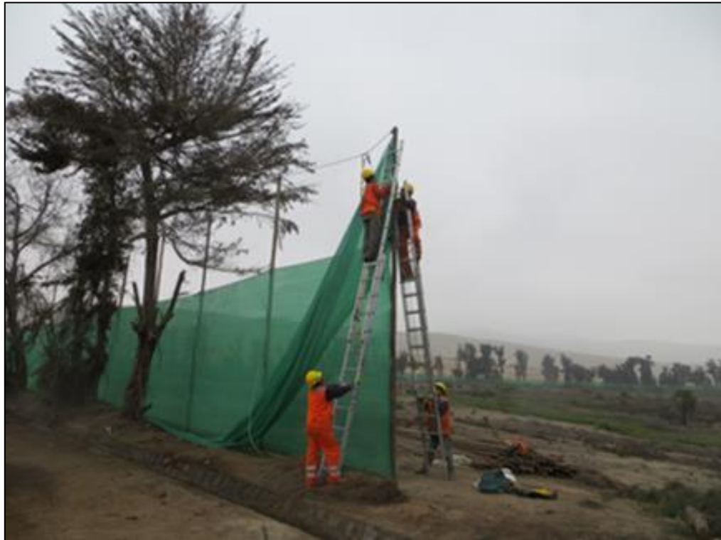
PROCESO 17. Instalación de malla Raschel a 6.0 m.
