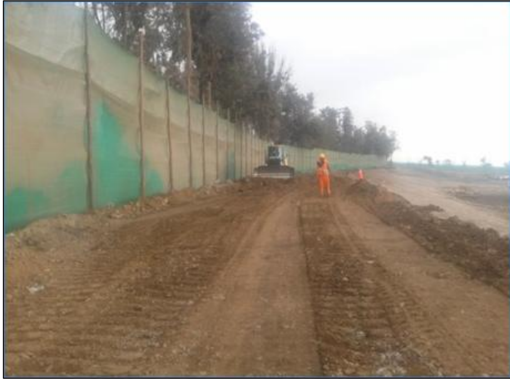
PROCESO 18. Relleno para instalación de cerco perimétrico prefabricado.
