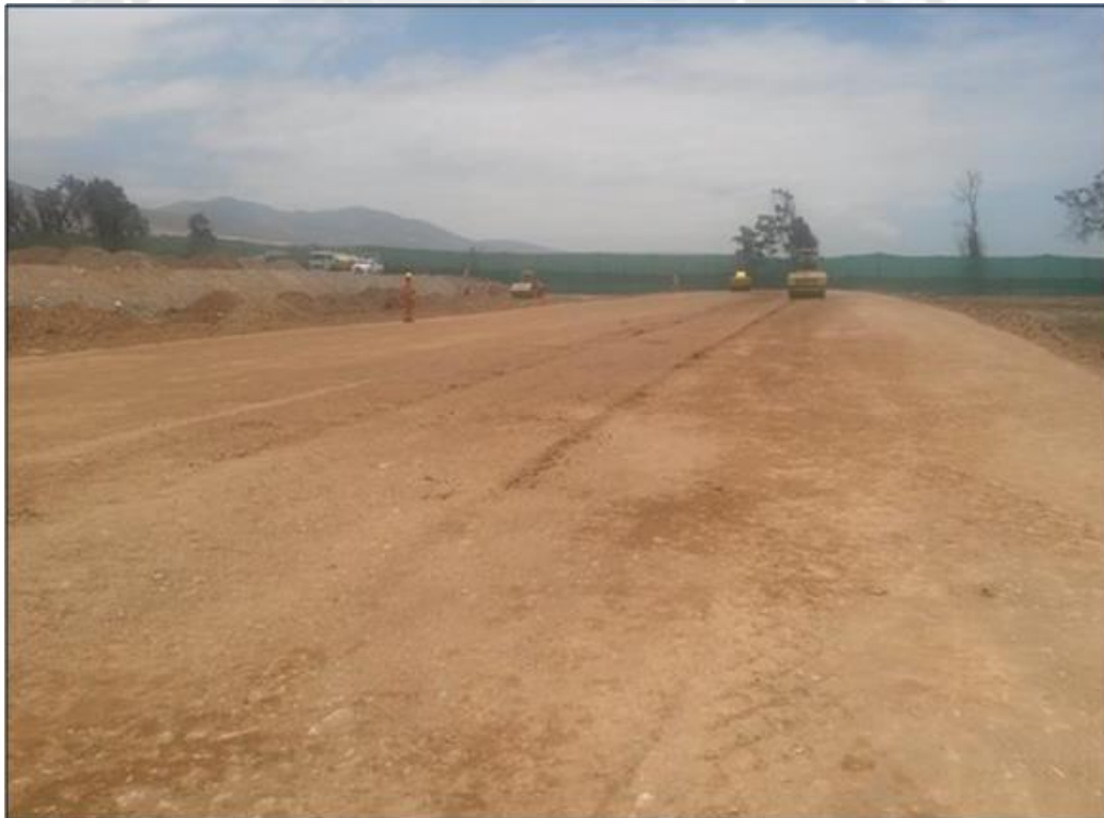
PROCESO 14. Relleno con material de préstamo.
