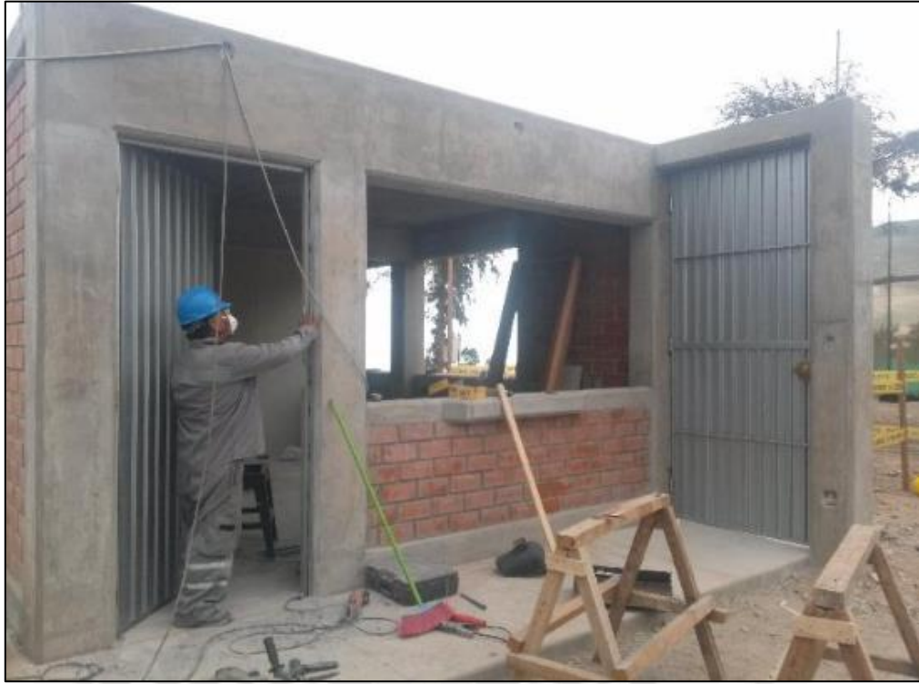
PROCESO 18. Construcción de garita de control.
