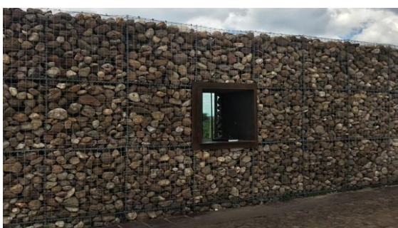
Figura N° 110. Materialidad de gaviones
