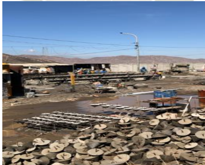
Foto 12: Zona de Centrifugado de Postes
