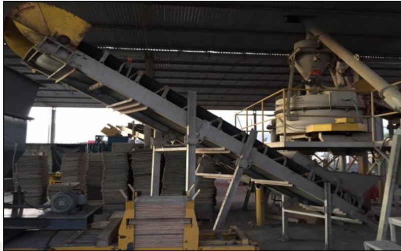
Foto 14:Faja transportadora de concreto para adoquines
