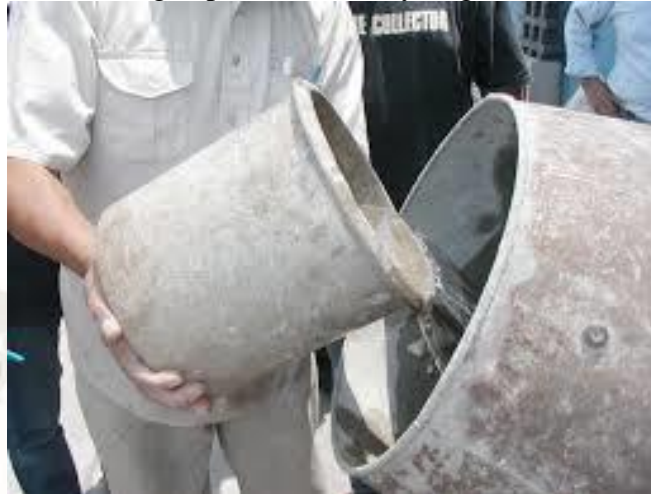
Foto 10: Agua para mezclado y fraguado de concreto
