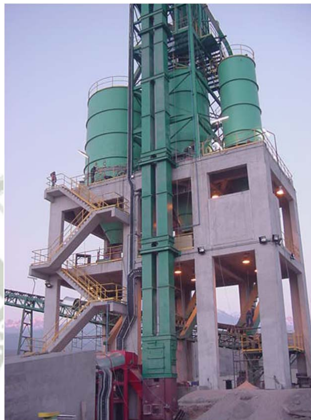
Imagen A6: Elevador de cangilones de clinker y tolvas de materias primas
