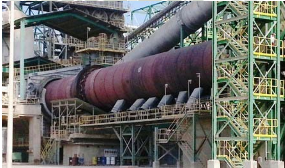
Imagen A9: Horno rotativo, ventiladores de caso y filtro
