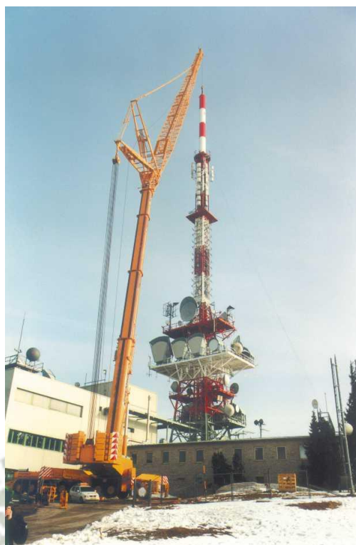
Figura 32 Sistema de transmisión digital (Sistema radiante y transmisor)
