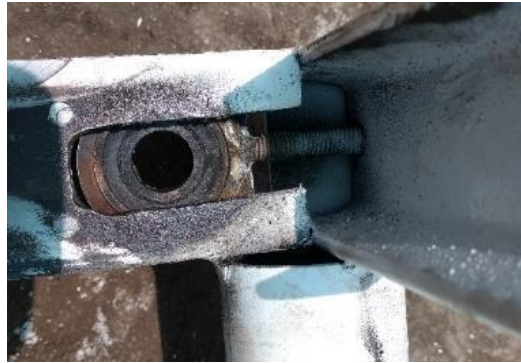
Figura 30. Instalación de los rodamientos
