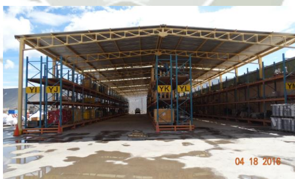
Figura N° 31: Almacén Patio-Zona Racks II
