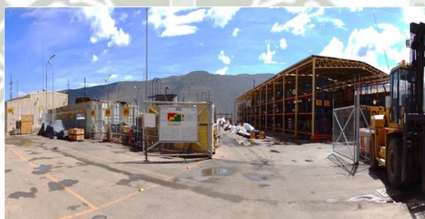
Figura N° 30: Almacén Patio-Zona Racks
