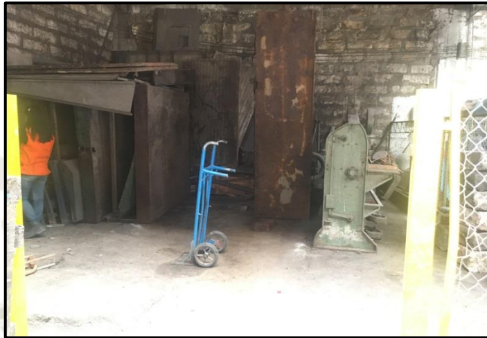
Figura 62: Retiro de elementos del A. de Residuos No Peligrosos
