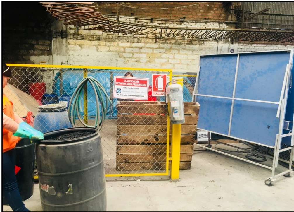
Fuente: Almacén de Residuos Peligrosos
