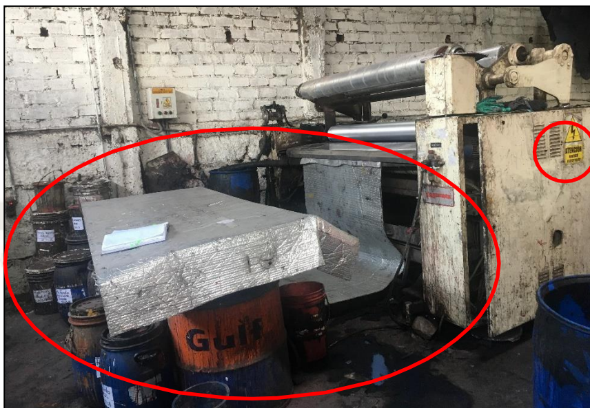
Figura 20: Elementos químicos fuera de su área y falta de mantenimiento
