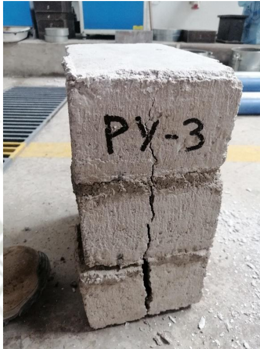
Foto 43 Falla de Separación del frente Superficial del Lado A del Prisma Patrón con Cemento Yura IP de la Primera Etapa.
