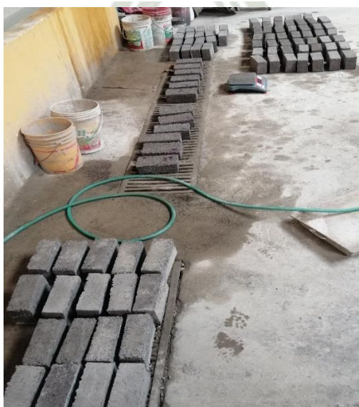
Foto 32 Elaboración de Ladrillos Primera Etapa
