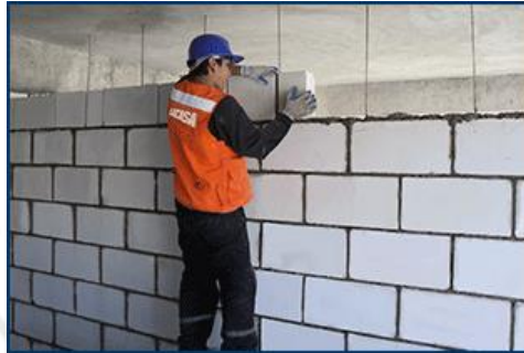
Figura 3 Colocación de Bloques Sillico Calcáreos
