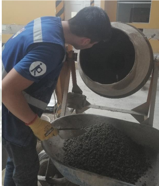
Foto 39 Vaciado de Mezcla para los Ladrillos
