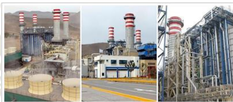
Figura 06: Vista general de la central Fuente: Edegel.
