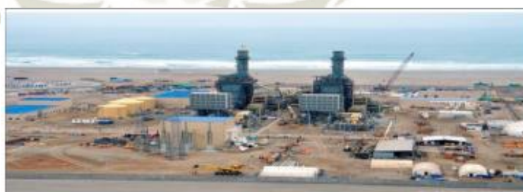
Figura 03: Vista de la central termoeléctrica
