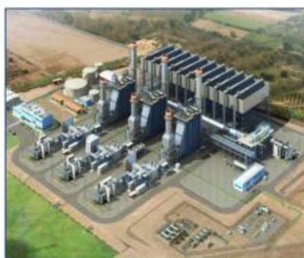
Vista General de la central
