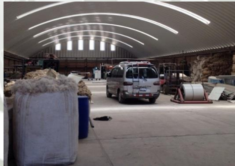
Figura 60: Hangar Local Zona Industrial Umopalca (Urbanía, 2016b)
