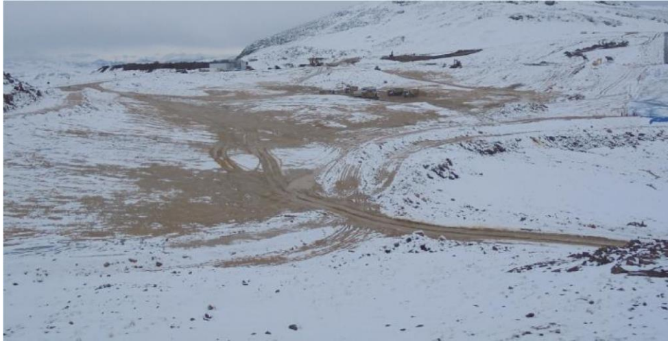
Vista de trabajos de colocación de la sub rasante y rasante
