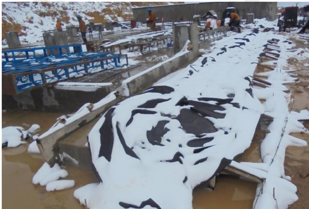
Vista de los trabajos realizados en el Taller de Volquetes.
