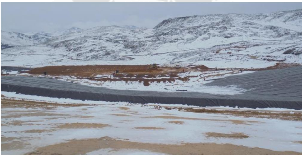
Vista de trabajos en el Extendido de Over en el sector 01
