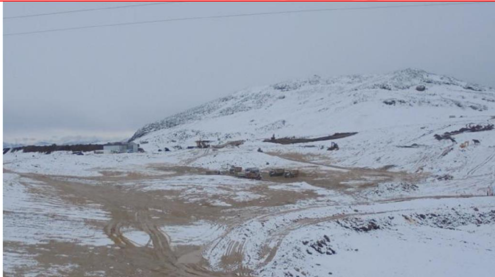
Vista de trabajos de eliminación de material inorgánico peat
