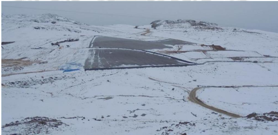
Vista de trabajos de la instalación de Geomembrana y conformación de Bermas Perimétricas.
