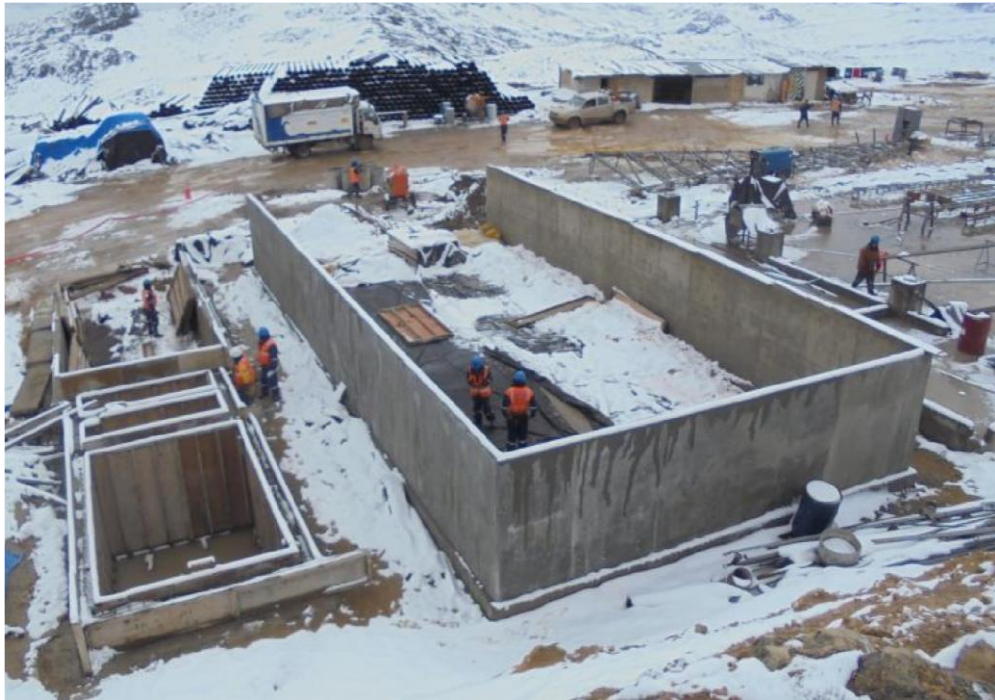
Vista de trabajos en Lavadero de Equipos
