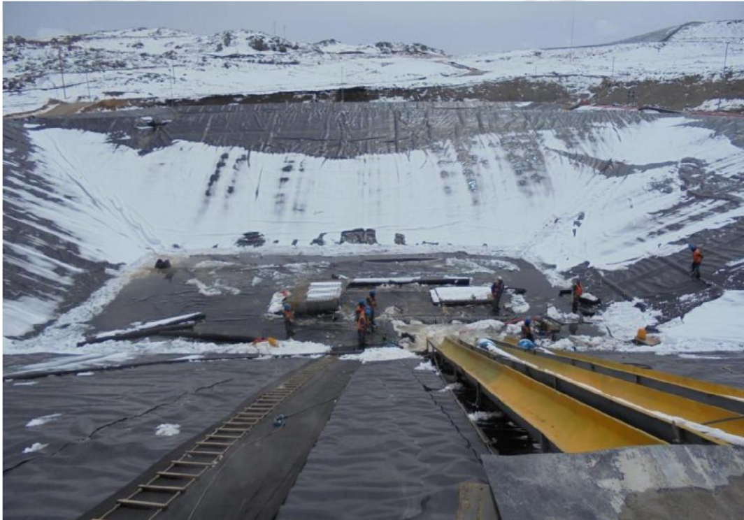
Vista de trabajos en la ubicación de la fuga de agua en la Capa Primaria
