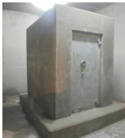
Vista de los trabajos realizados en el Planta MC.
