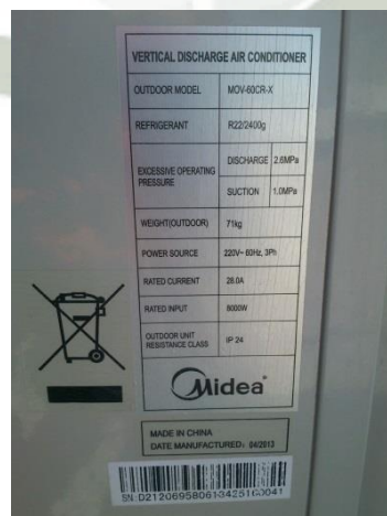
Figura4.1: Placa de datos del sistema mecánico Midea.
