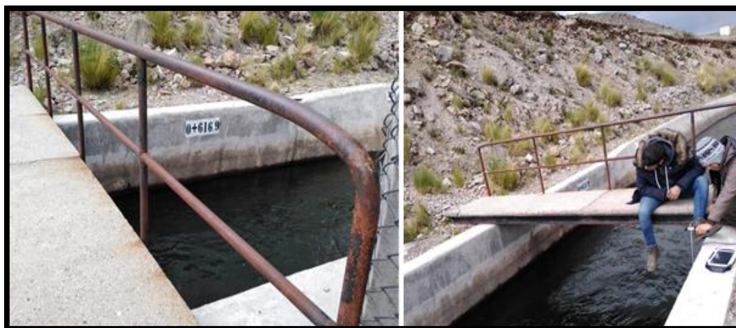
Figura 105. Punto de aforo progresiva 0+616.9. Fuente: Figura elaborada por el autor, 2019.
