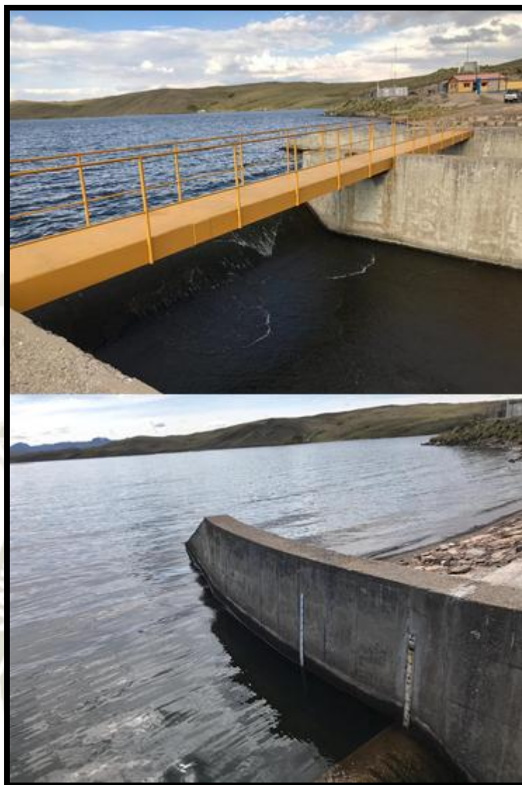
Figura 24. Aliviadero (Detalle de la mira limnimétrica) de la Represa El Pañe. Fuente: Figura elaborada por el autor, 2018
