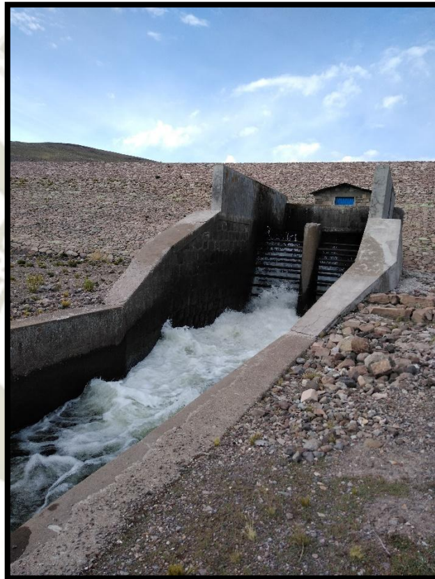
Figura 22. Tanque de Disipación y Compuerta de Regulación N° 2 de la Represa El Pañe. Fuente: Figura elaborada por el autor, 2018
