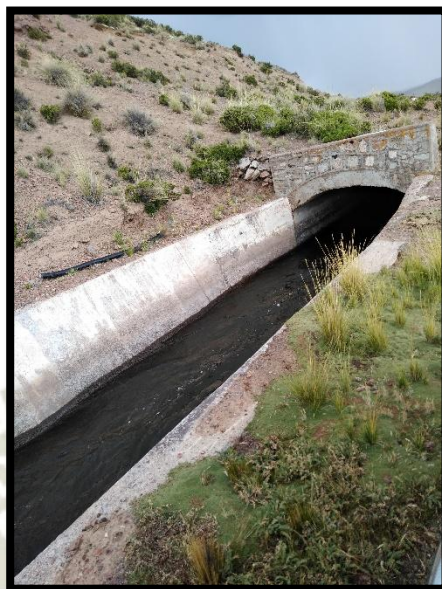
Figura 108. Inicio del tramo del canal techado.
