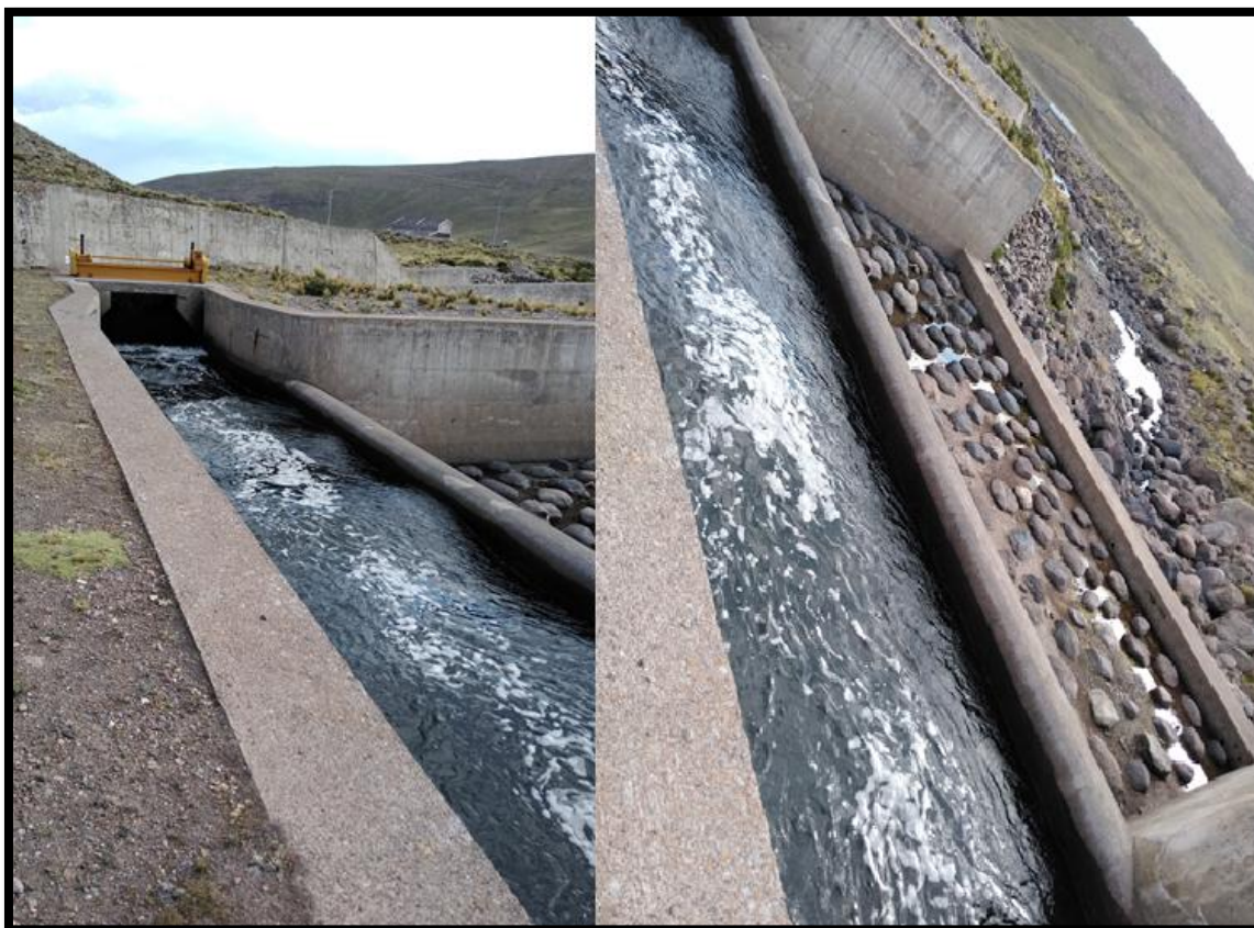
Figura 23. Compuerta de Amortiguamiento N° 3 de la Represa El Pañe.
