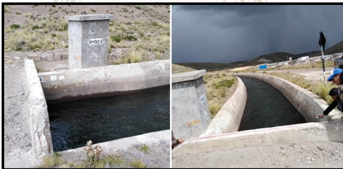
Figura 103. Punto de aforo progresiva 0+262.4. Fuente: Figura elaborada por el autor, 2019.
