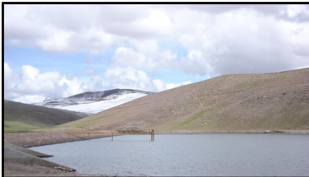
Figura 20. Puente de maniobras que opera la Compuerta de Fondo N°1 de la Represa El Pañe.
