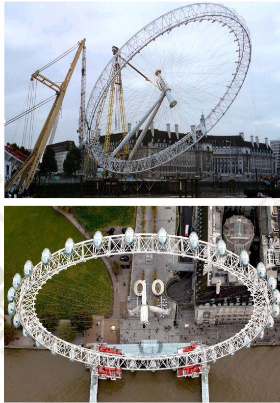
Fig. 1 - Fig. 2 Proceso de montaje del London Eye & Vista lateral del London Eye
