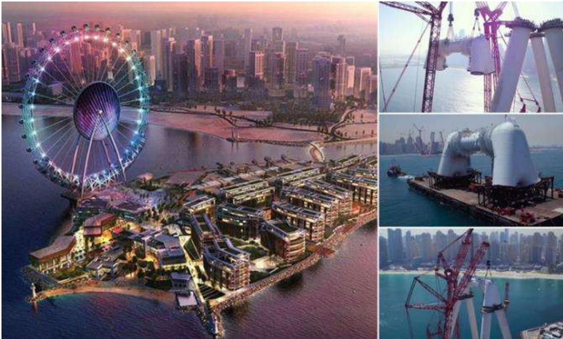
Fig. 12 Vista General del Ain Dubai, y detalles de montaje del spindle & hub central.
