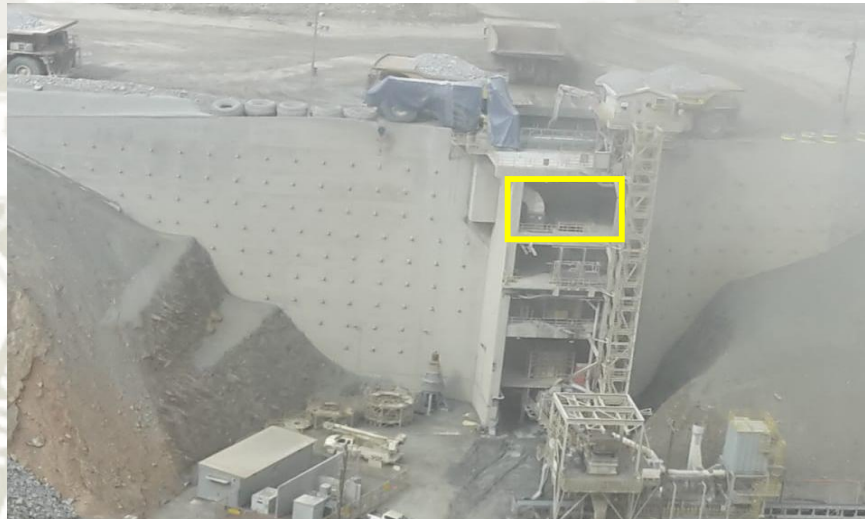
Figura 3.3. Ubicación compresor CPT DLIX Fuente: (Elaboración Propia)
