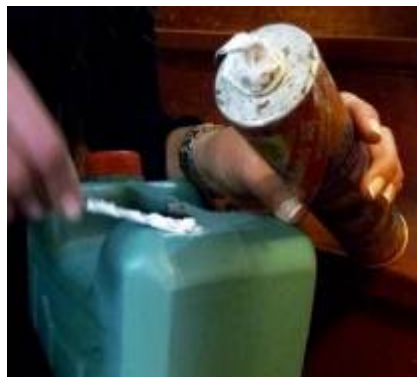
Figura 48. Sellado hermético de los puntos de medición en cada biodigestor.
