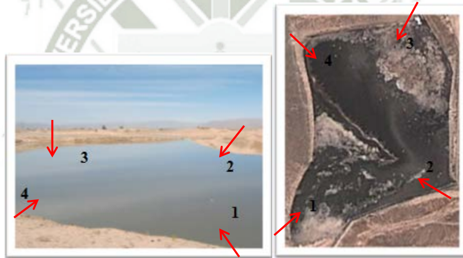
FIGURA N°9 . Vista Panorámica de la Laguna de Oxidación del Parque Industrial de Río Seco, Arequipa
